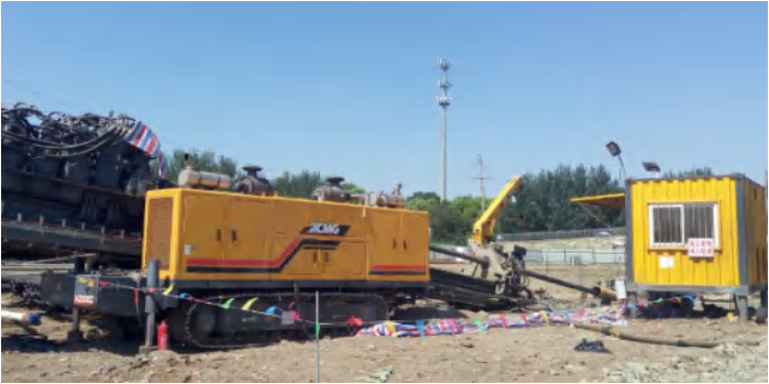
图4 XZ3000水平定向钻辅助钻机施工现场
