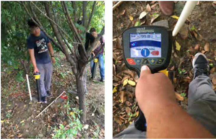
（图二）现场在进行发射机和测试桩连接线的连接调试，接收机可清晰的显示1016mm管道深度是9.4米
