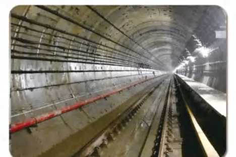
盾构施工完成
