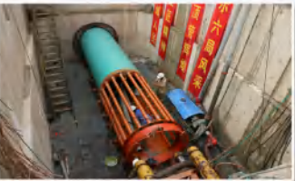
钢管顶进施工
