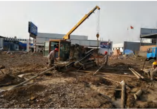
图7扩孔施工场地
