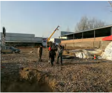
图5施工场地河内管线勘测中
