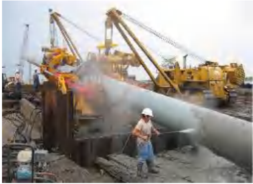
图 2-21 回收旧管道和管内铺管
