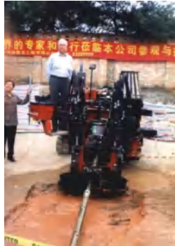
图 2-19 定向钻进施工现场
