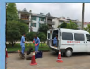
CCTV电视检测
