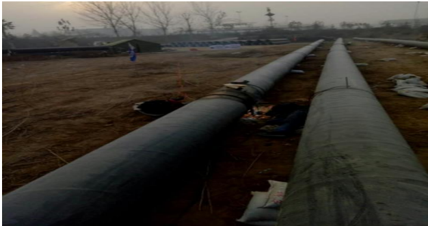
图 2 施工场地焊接管道
