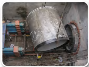
安装顶进管节
