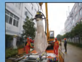
检查井整体内衬修复
