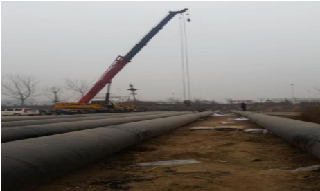
图13 吊装管道作业中
