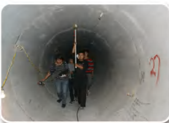
顶管内部雷达检测
