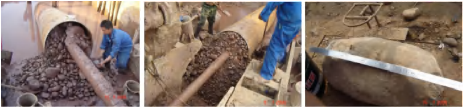
图3.5 施工现场绞龙从套管内排出卵石
