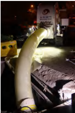
图 2-31 北京天环压力管道翻转内衬修复
