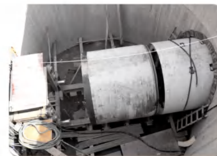
顶管施工
