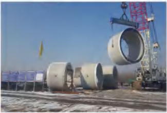
我公司制作的DN4400顶管运抵现场
