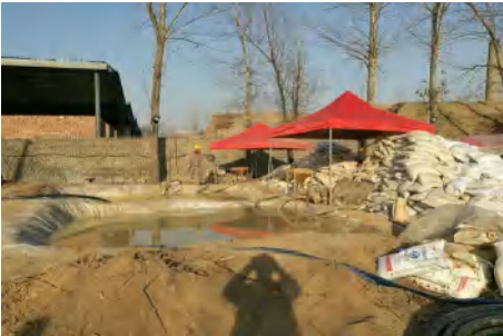
图10泥浆调配场地
