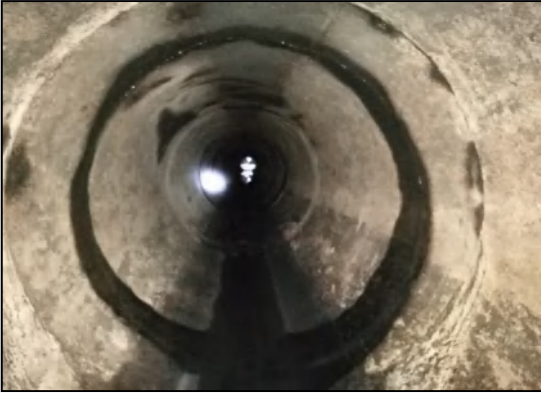
图-5 内衬施工前管内情况
