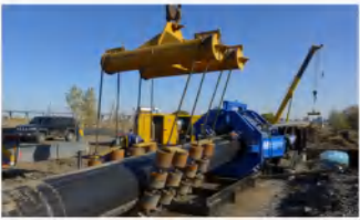
定向钻管道回拖推管机助推钢管
