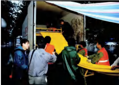
图 2-23 翻转内衬管道修复工程施工现场
