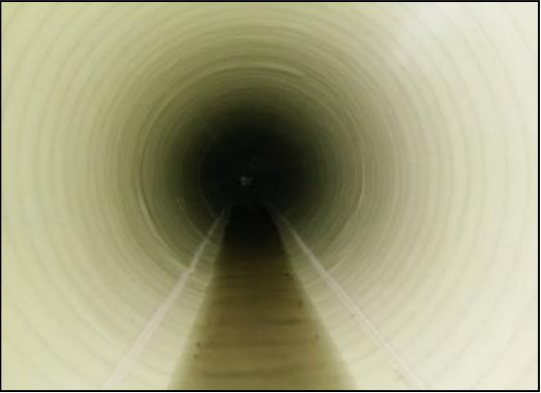
图-6 内衬施工后管内情况
