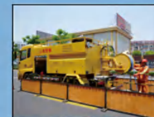
管道疏通养护
