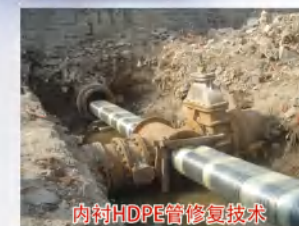
内衬HDPE管修复技术
