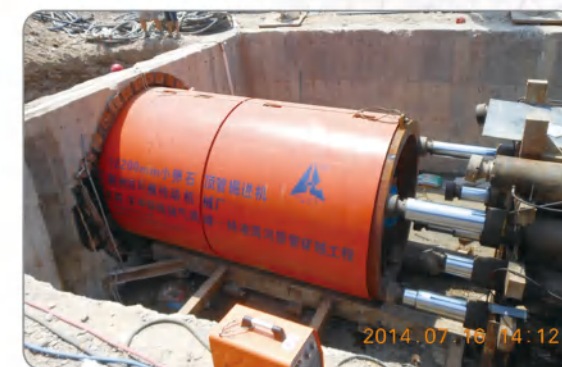
HKTP \phi 2200 mm小卵石顶管掘进机在陕西西安渭河施工工地
