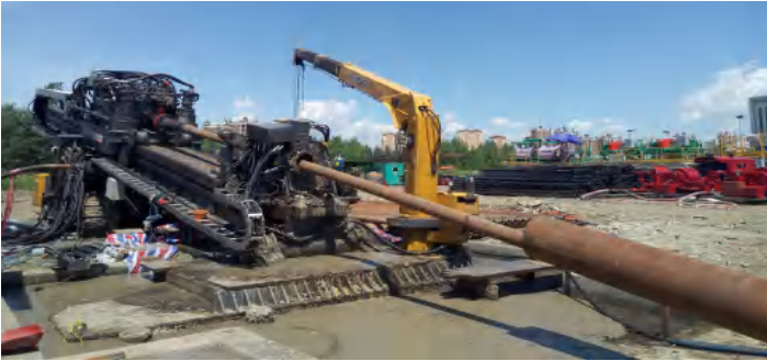
图3 XZ5000水平定向钻主钻机施工现场
