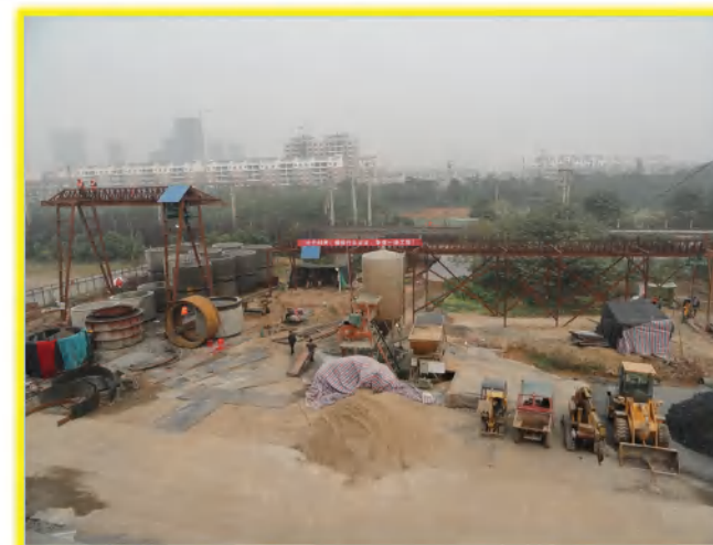
工地现场制做大口径砼管
