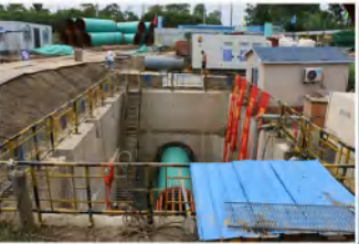
盐城市新水源地顶管安装施工现场
