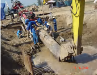
图3.2 准备顶入第一根套管
