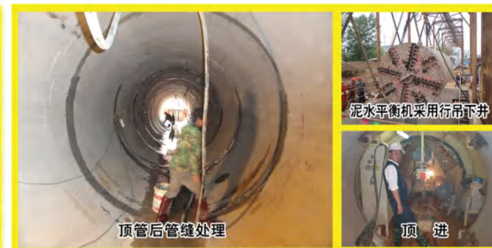
顶管后管缝处理 顶进 桃仙机场中心变电站66K护管涵穿越沈阳绕城高速（K52+711.5）、机场高速（K8+286）工程提前竣工保证了桃仙机场新建T3航站楼设施顺利供电，为沈阳“十二运”完美召开奠定了基础。 管径：DN2.6m×D3.12m加强型钢筋砼管 顶管长度130m、116m，工期60日历天。
