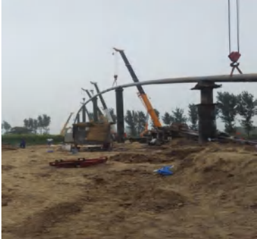
图3.15 顶管发送现场图
