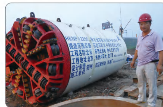
HKNP \phi 2200 北京西六环千灵山风景区大灰厂路施工现场
