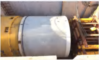
钢筋混凝土管顶进施工
