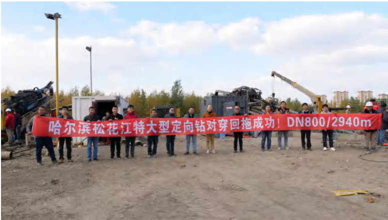
图 8 管道铺设成功
