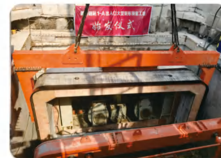
矩形顶管施工
