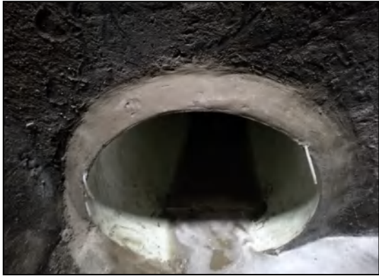
图-4 管口处理后情况
