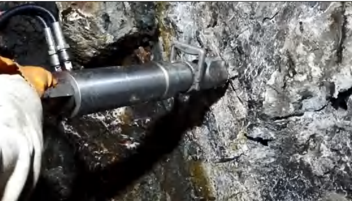
劈裂机劈裂岩石
