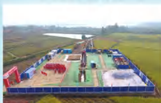
新气长江定向钻施工现场
