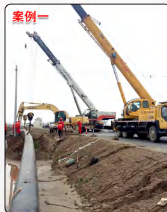
如东-海门-崇明岛输气管道工程
