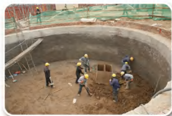
圆形顶进坑施工
