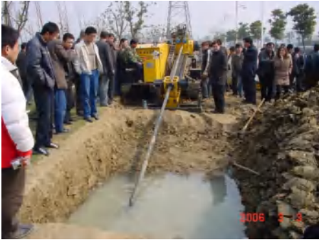
图 2-32 施工现场参观
