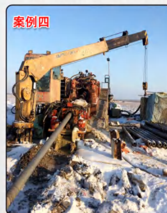
衡阳市北二环燃气主干管湘江穿越工程
