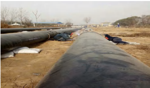
图8-1焊接管道施工场地
