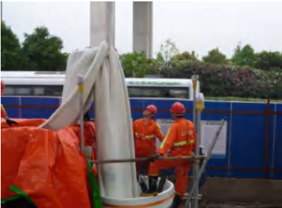
图 2-29 上海管丽公司大直径 CIPP 管道修复
