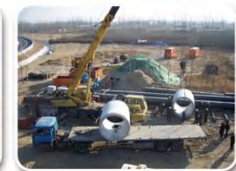
南六环太和东桥燃气顶管施工现场
