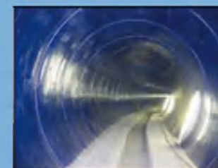
3S模块拼装管道修复
