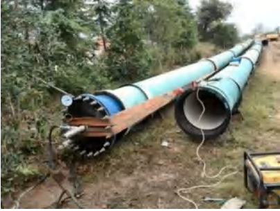
图8 管线试压
