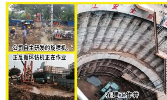
顶管后管缝处理 顶进 桃仙机场中心变电站66K护管涵穿越沈阳绕城高速（K52+711.5）、机场高速（K8+286）工程提前竣工保证了桃仙机场新建T3航站楼设施顺利供电，为沈阳“十二运”完美召开奠定了基础。 管径：DN2.6m×D3.12m加强型钢筋砼管 顶管长度130m、116m，工期60日历天。
