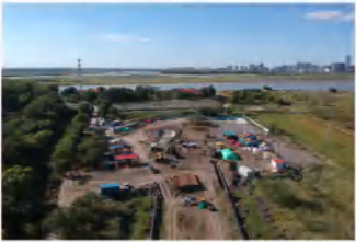
两台600t定向钻机同时施工现场
