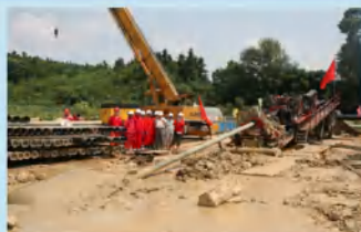
西二线漯河定向钻穿越
