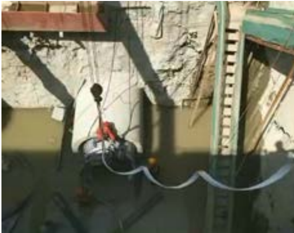
地下 10 米深基坑
