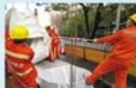
内衬软管准备下管
