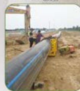
河北管网改造
