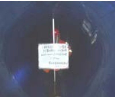
图 5 内衬管内径检测
