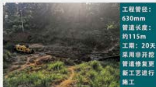
4 大龙经开区二号干道污水管网抢修工程
