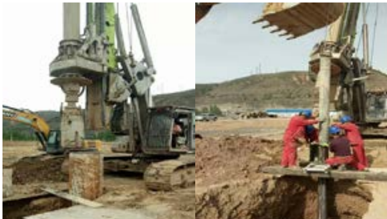
旋挖钻施工
