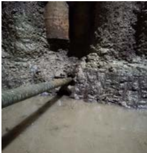
导向顺利进入热力深基坑内
