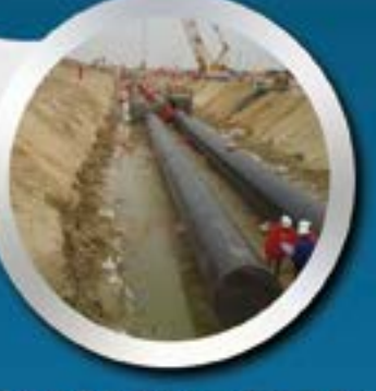
中委合资广东石化2000万重质原油 加工工程厂区给排水消防网管 工程沟下焊接
