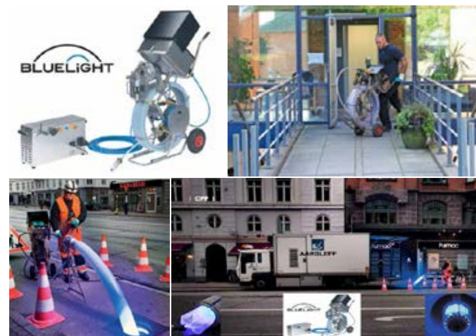
图 2-45 BLUELIGHT LED 固化系统与施工
