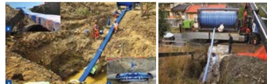
图 2-46 Primus Line® 普莱姆斯软管法施工
