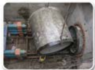
安装顶进管节
