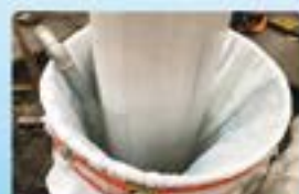
水力翻转送入内衬软管
