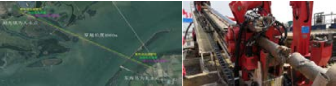
图 2-16 湛江东海岛输油管道穿越工程
