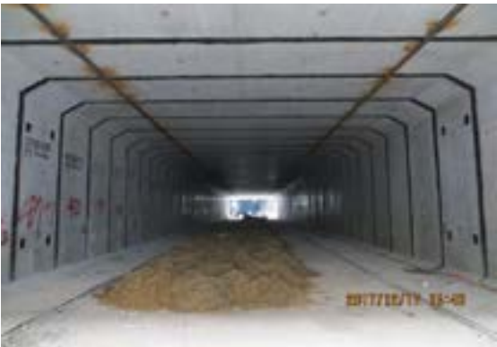
图 2-26 武汉地下人行通道采用矩形顶管
