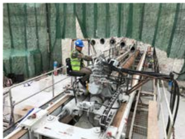
图 2-39 隧道圆拱上的 Bohrtec BM 600 LS
