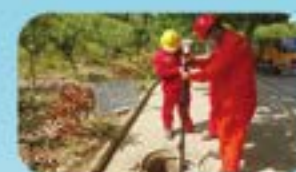
排水管网检测
