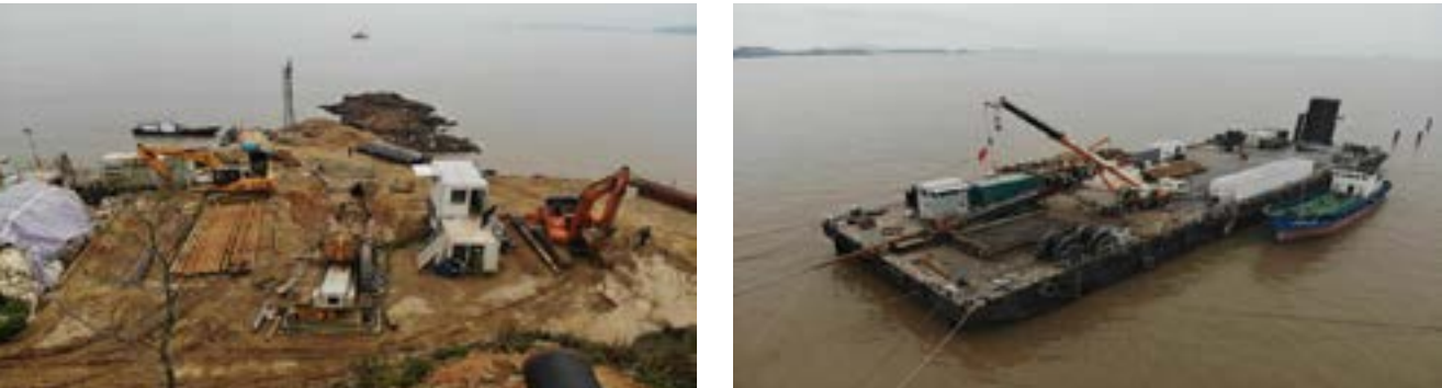
海陆水平定向钻施工现场
