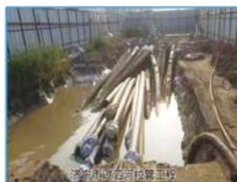
济宁市外为主管道 管泥水平衡工地
