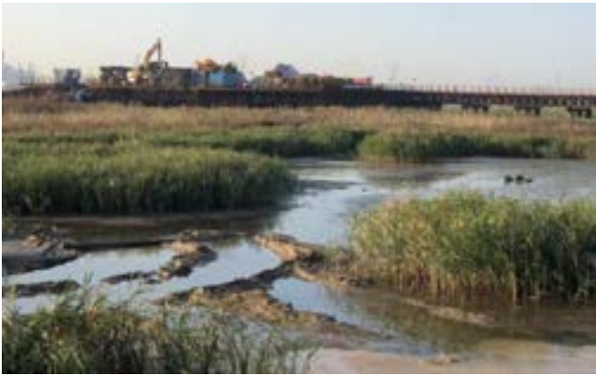
沿海滩涂地水平定向钻施工现场
