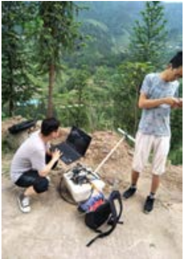
上山帮业主测供水管道漏水
