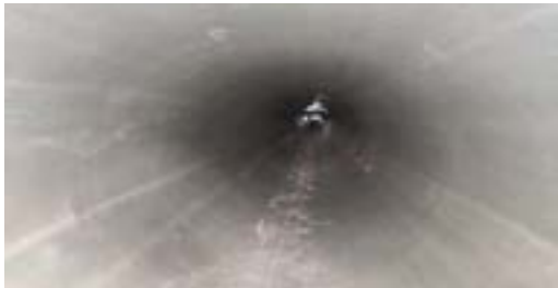
图 2-52 北京隆科兴 UV-CIPP 修复压力管道
