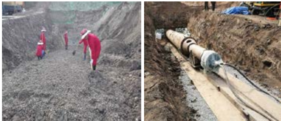
图 2-37 汶江定向钻穿越工程夯套管基坑与设备就位
