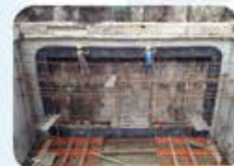
止水橡皮圈安装
