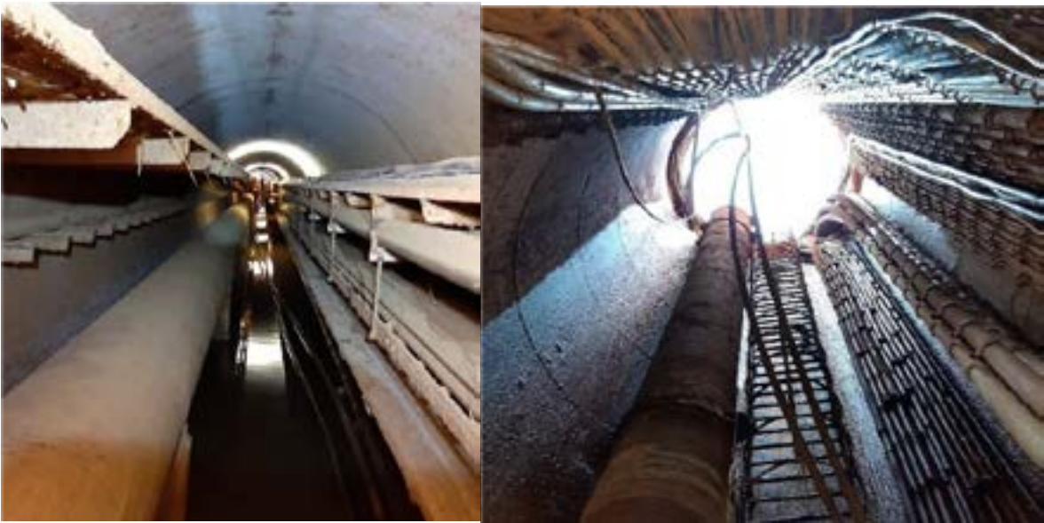
图 4 图 5 管廊及管井现场照片
