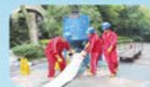
排水管网非开挖修复
