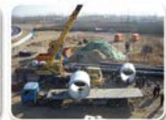
南六环太和东桥燃气顶管施工现场
