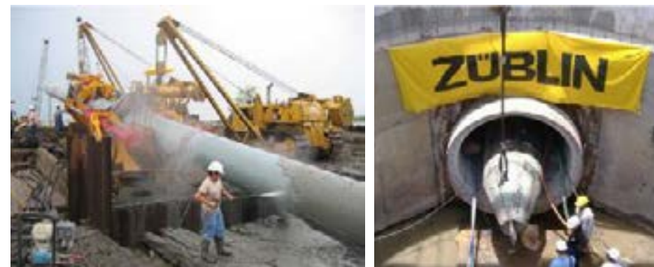
图 2-42 回收旧管道和管内铺管
