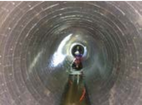
图 3 内衬管外观验收检测
