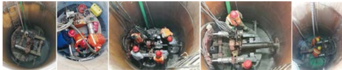
① 设备安装 ② 徕卡导向仪安装 ③ 顶进前导管 ④ 前导管与黑管连接 ⑤ 黑管顶进
