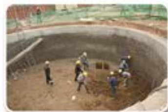
圆形顶进坑施工
