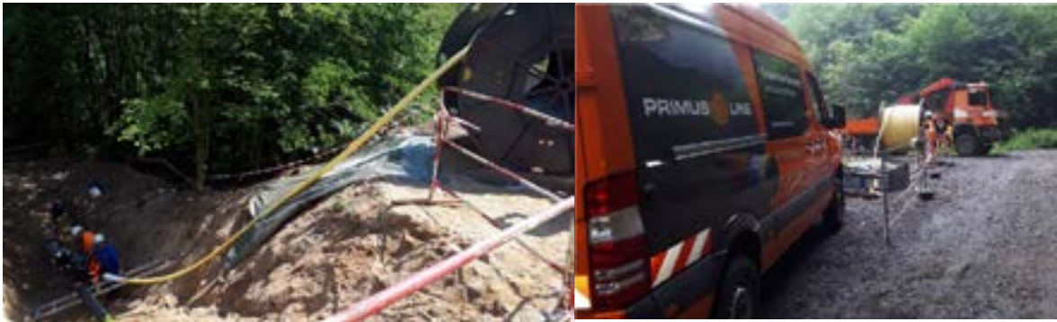
图 8 图 9 现场施工安装中
