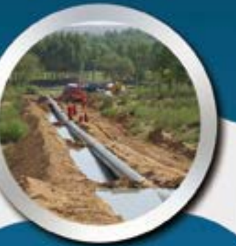
8管线发送 (陕京三线榆溪河 \phi 1016 \times 870\text{m} )
