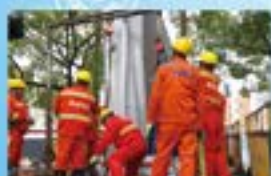
内衬软管下管
