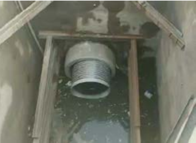
一次性完成 167 米修复
