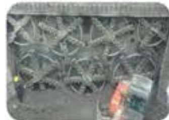
矩形顶管机出洞门
