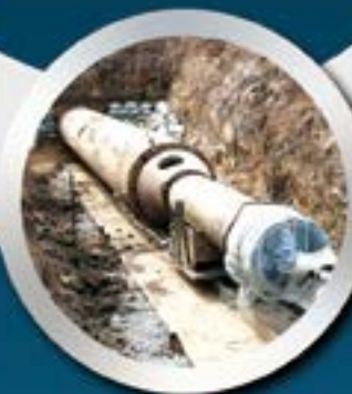
长吉线岔路河穿越段 安全改造工程—夯锤施工
