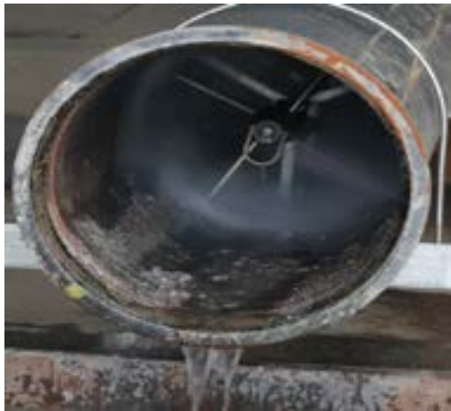
图 5 超高压水清洗
