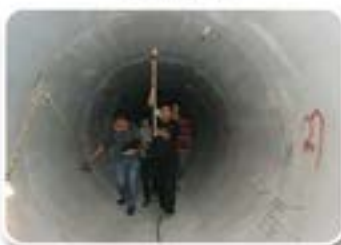
顶管内部雷达检测
