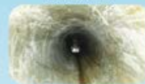
修复后管道内部
