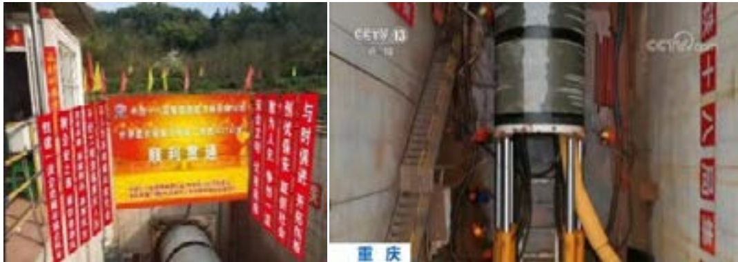
图 2-27 创世界纪录的重庆引水隧道 3224 m 顶管工程
