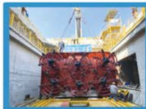
6.9*4.2m多刀盘土压平衡矩形顶管机
