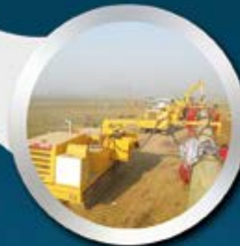
焊接工程-冀宁线大汶河 河道治理工程大汶河 河道治理工程组对焊接预制
