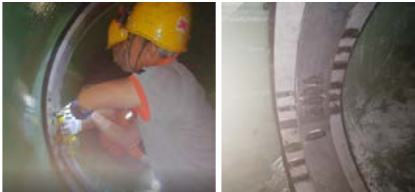
图 5-5 双胀圈连接接口
