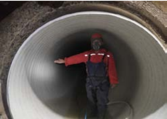
大口径管道修复
