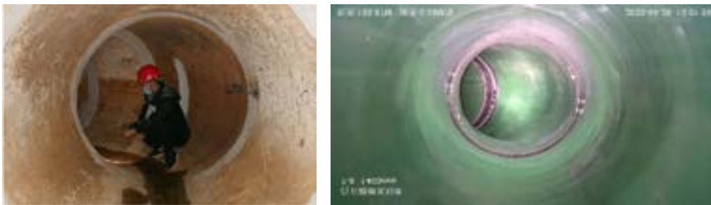
图 5-4 弯头固化前后对比程
