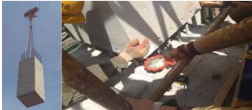
框架柱柱底钢筋连接
