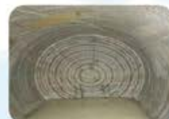
135mpa岩石顶进机头拉出后岩洞
