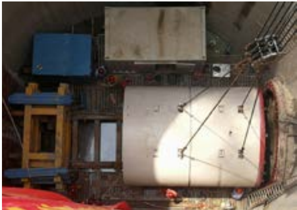
顶管机吊放安装
