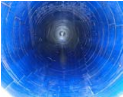
图 4 内衬管外观验收检测
