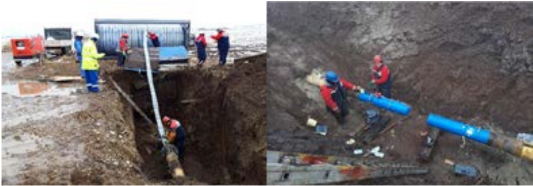
图 6 图 7 现场施工作业中
