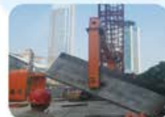
矩形管节翻转及吊装
