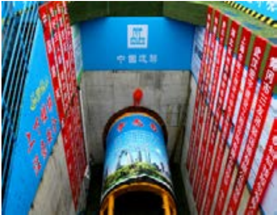
图 2-28 湖北黄冈综合管廊顶管工程
