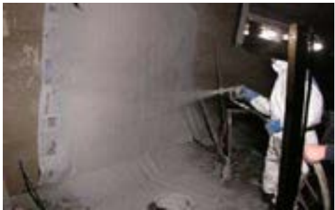
2-51 改进后的玻璃纤维贴片法修复
