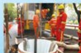
连接锅炉，循环加热固化
