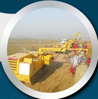
焊接工程—冀宁线大汶河 河道治理工程大汶河 河道治理工程组对焊接预制
