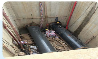
王英水库引水岩石顶进工程
