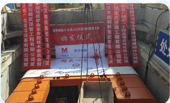
武汉地铁七号线一期新华路附属矩形顶管工程
