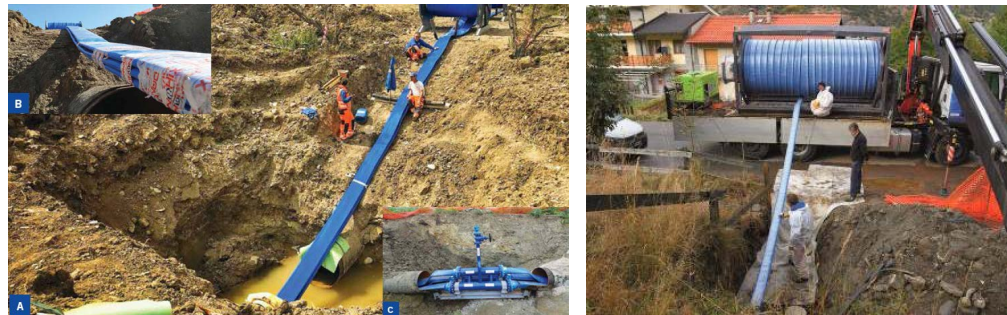
图 2-75 Primus Line® 普莱姆斯软管法施工
