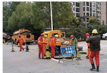
雨污水管网修复工程（绿地集团）
