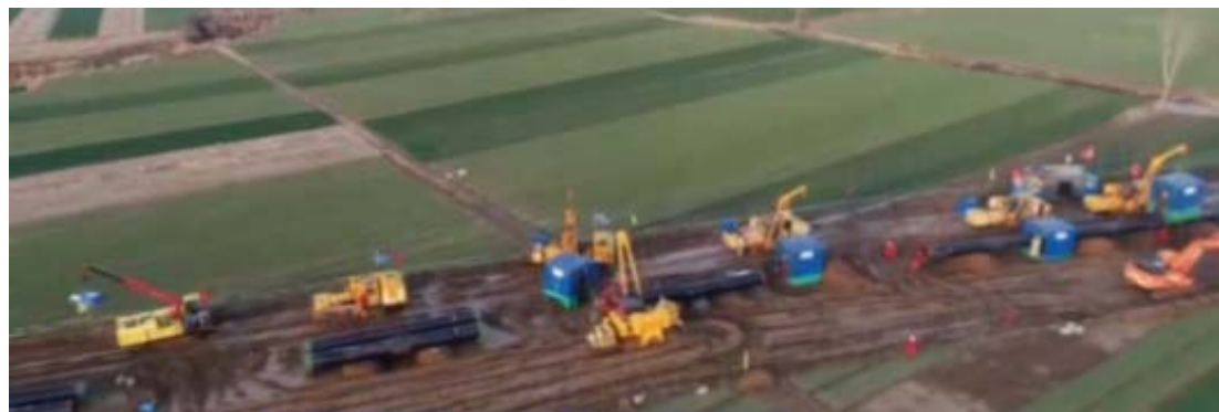
图 2-29 滹沱河定向钻穿越工程
