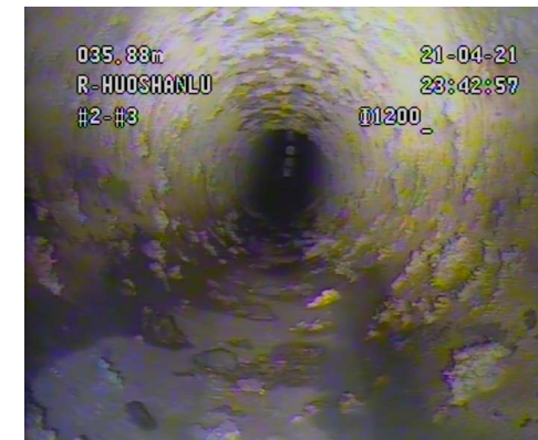
图 7 超高压清洗管道前原始情况
