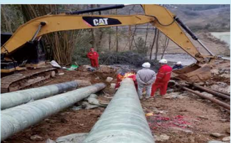
遵义市正安至务川天然气输气管道芙蓉江定向钻穿越工程
