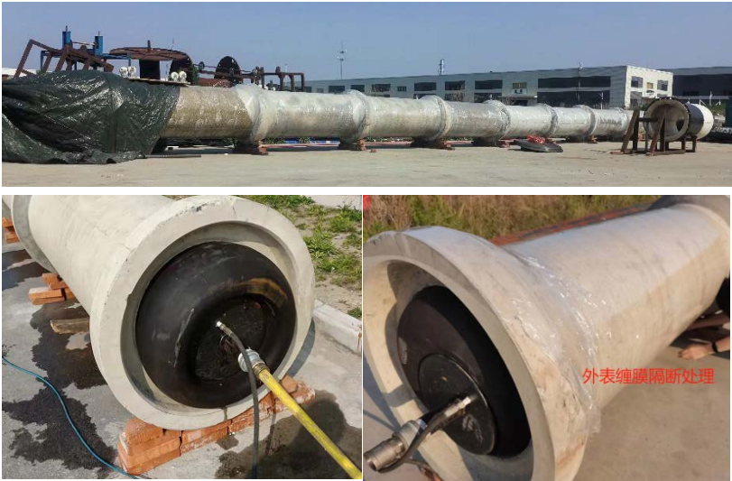
图 1 DN600 混凝土管道浸泡
