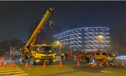
图 6 保证安全施工现场
