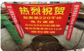
赵家条220千伏电力通道土建工程
