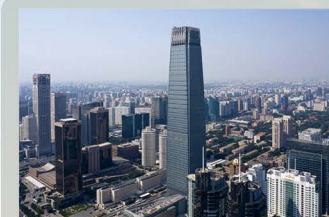
中国国际贸易中心三期燃气工程
