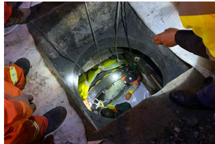
图 14 安装两端扎头
