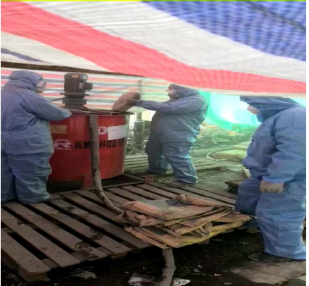
管道严密性试验、注浆、保温
