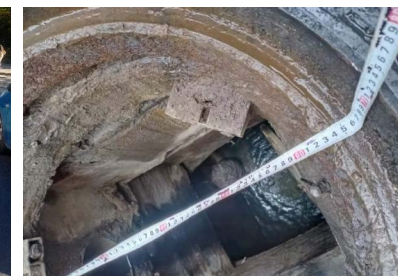
图5 测量检修井口径
