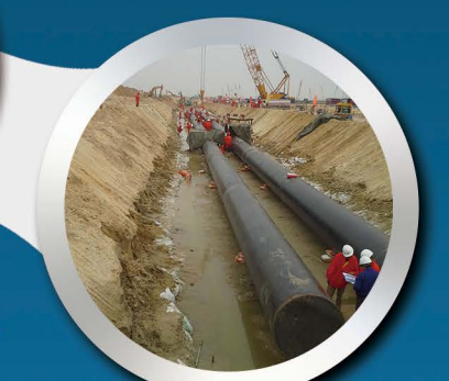
中委合资广东石化2000万重质原油 加工工程厂区给排水消防网管 工程沟下焊接
