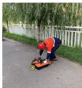
■ 商丘地下燃气 管道探测项目
