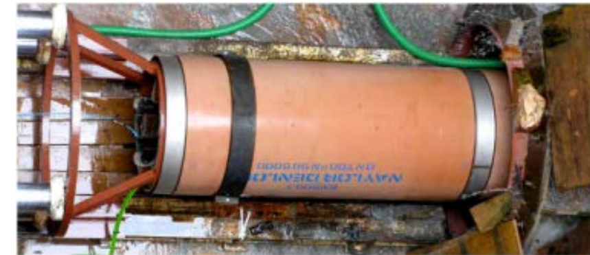
图 2-73 使用 Naylor Denlok 顶进进行插管修复
