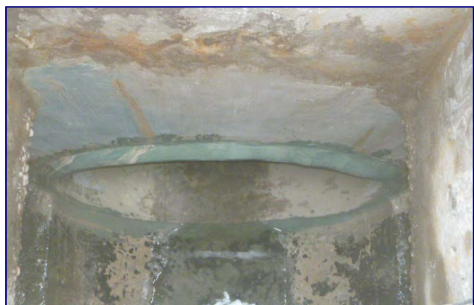
图 3 检查井内管道端部情况
