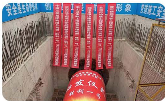
青菱路电缆隧道沉井及顶管工程
