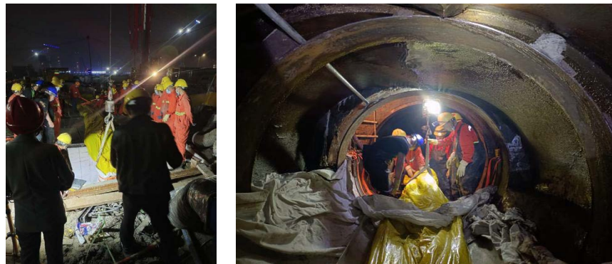
将内衬软管材料拖入管段中
