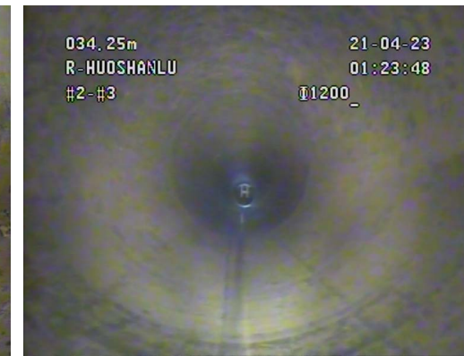
图 8 超高压清洗管道后管道内状况
