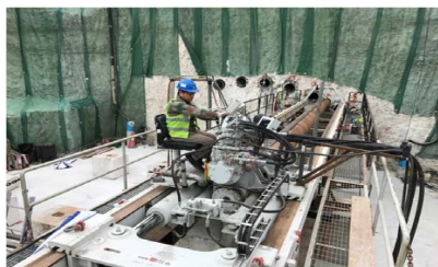
图 2-66 隧道圆拱上的 Bohrtec BM 600 LS
