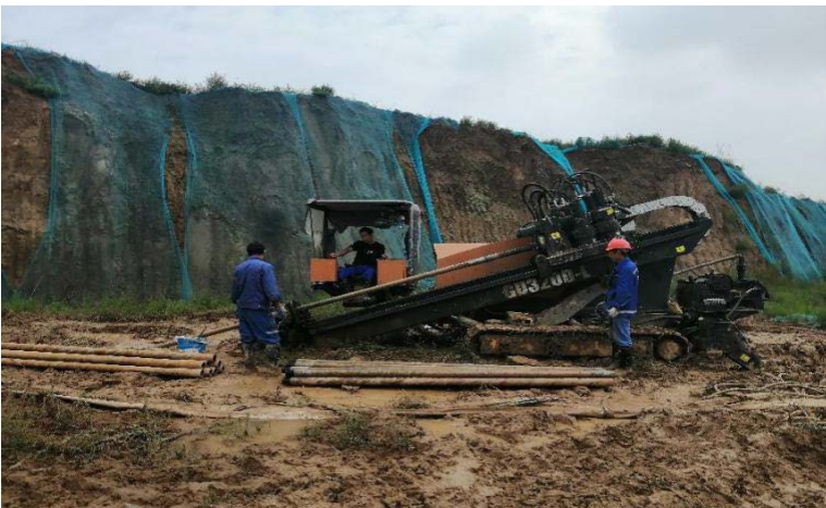
管线施工实景图
