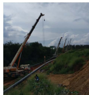
昆明市东绕城匝及拓翔路定向钻穿越工程(钢管)
