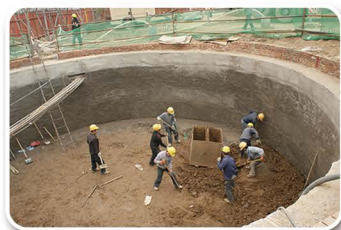
圆形顶进坑施工
