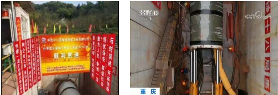
图 2-47 创世界纪录的重庆引水隧道 3224m 顶管工程
