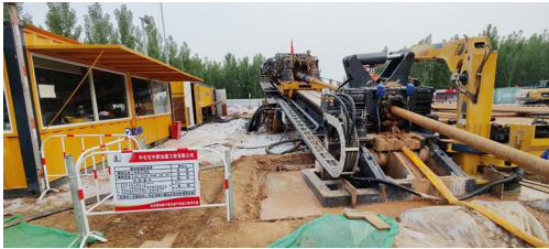
图 1b 入土点徐工 1200T 主钻机
