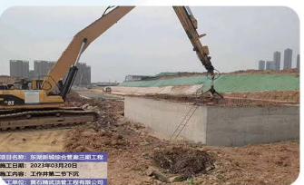
东湖新城综合管廊三期工程总承包EPC项目绿岛西路综合管廊顶管及顶管井工程
