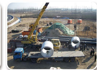
南六环太和东桥燃气顶管施工现场
