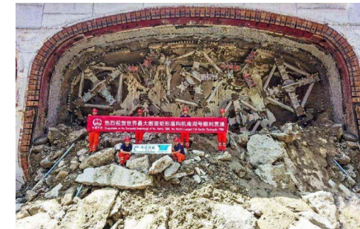
图 2-60 中国最大断面盾构机顺利贯通
