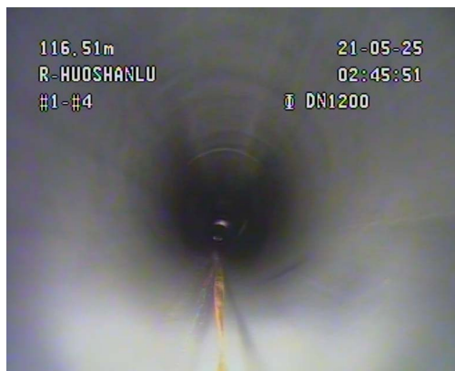
图 11 经 CIPP 常温固化翻转内衬修复后管道
