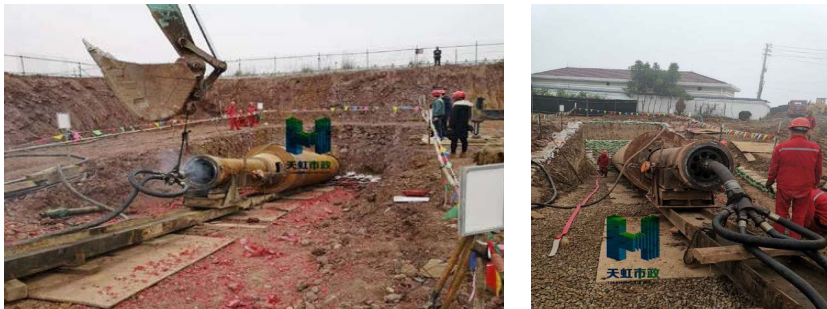
图 2-64 南充市原水管道穿越嘉陵江工程
