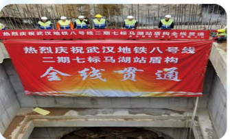
武汉市轨道交通8号线二期第七标段盾构区间段工程
