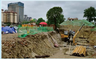
贵阳市花溪湖水系退水管道定向钻穿越工程
