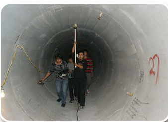
顶管内部雷达检测
