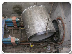
安装顶进管节
