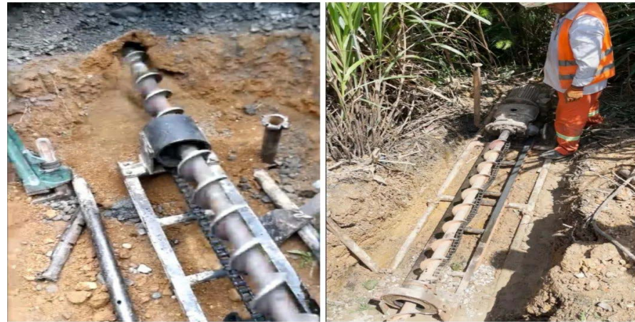
地下横向钻孔排水
