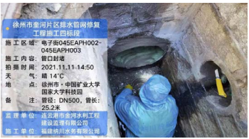
图 3 管口封堵
