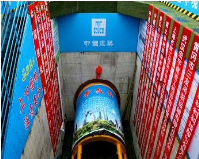
图 2-48 湖北黄冈综合管廊顶管工程
