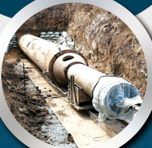
长吉线岔路河穿越段 安全改造工程—夯锤施工
