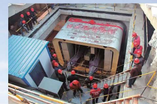
矩形土压平衡顶管机
