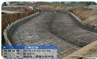
河口排洪港建设工程
