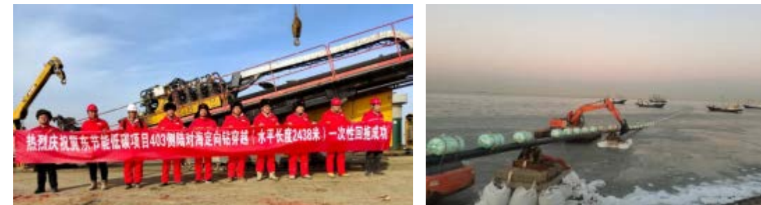
图 2-30 冀东油田 403 侧陆对海穿越工程
