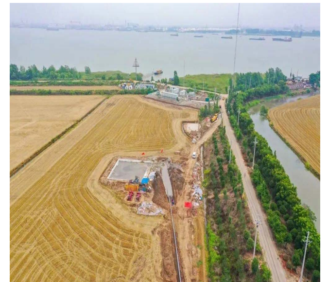
马洲岛拉管施工作业现场
