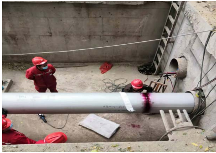
焊接、检测、牵引拉管
