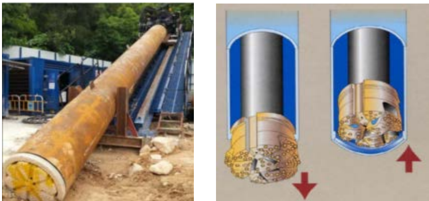
图 2-65 潜孔锤跟管钻进安装套管
