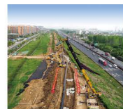
南京定向钻穿越风化岩项目
