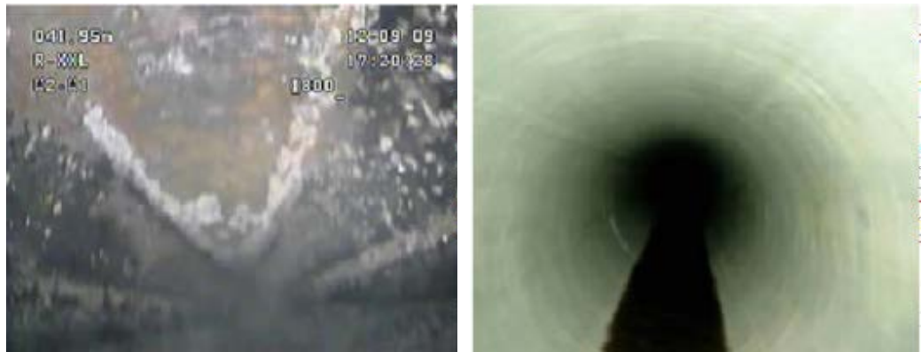
图 4 翻转式原位固化法内衬修复前后对比: (a) 修复前 (b) 修复后
