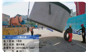
黄冈市地下综合管廊PPP工程
