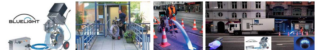
图 2-81 BLUELIGHT LED 固化系统与施工
