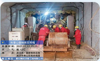
武汉轨道交通5号线科普公园站工程
