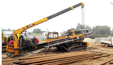
图 2 出土点徐工 360T 辅助钻机
