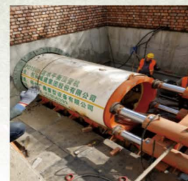
包头市西河总干污水管线工程
