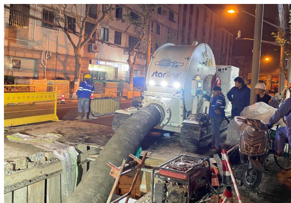
图 10 CIPP 常温固化翻转内衬修复施工
