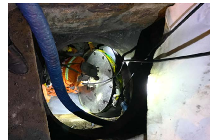
图 16 安装盖板
