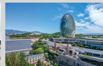
APEC日出东方酒店能源中心项目
