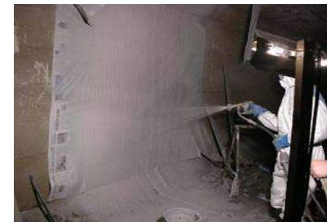
图 2-86 改进后的玻璃纤维贴片法修复
