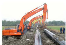
丹阳自来水定向钻穿越项目
