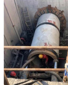
■ 浙江舟山φ1800mm 水泥顶管项目
