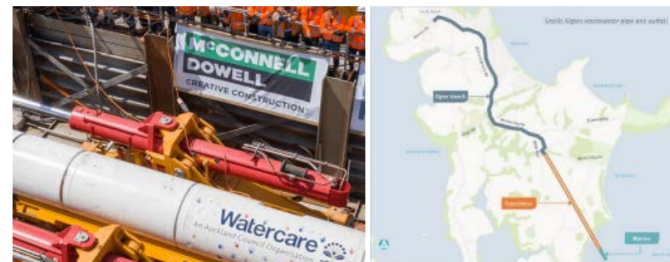
图 2-70 2021m 新世界记录直推管工程
