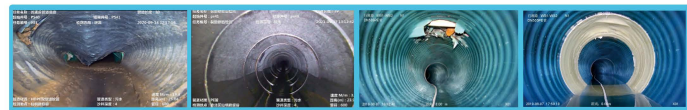
静压裂管修复前后
