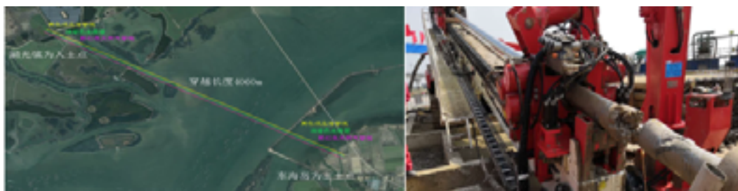
图 2-31 湛江东海岛输油管道穿越工程
