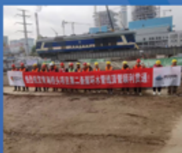
火电机组项目循环水顶管 EPC工程贯通仪式
