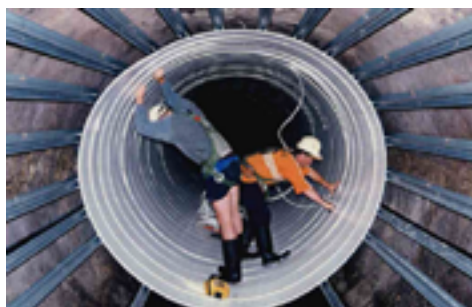
图 2-81 APS 迪拜公司的工人安装 Danby 螺旋缠绕内衬管
