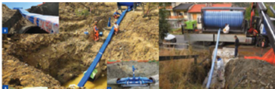
图 2-79 Primus Line® 普莱姆斯软管法施工
