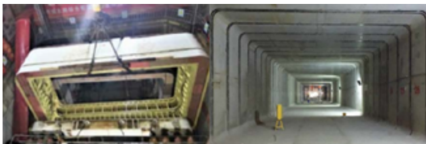
图 2-55 苏州城北路大断面矩形顶管中继间和管廊通道内景
