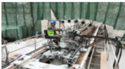
图 2-68 隧道圆拱上的 Bohrtec BM 600 LS
