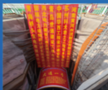
火电机组项目循环水顶管 EPC工程
