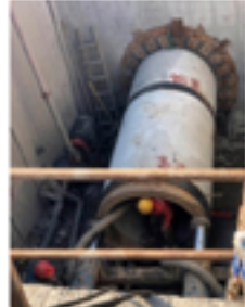
■ 浙江舟山 \phi 1800mm 水泥顶管项目
