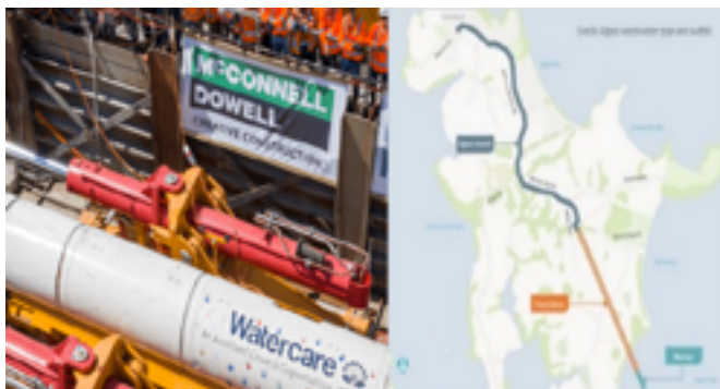
图 2-72 2021m 新世界记录直推管工程
