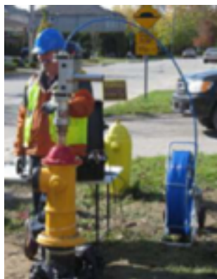
图 2-105 典型小直径 CCTV / 声学检测装置
