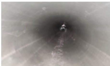
图 2-83 北京隆科兴 UV-CIPP 修复压力管道
