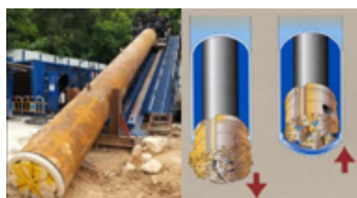
图 2-67 潜孔锤跟管钻进安装套管
