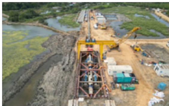
图 2-74 泰国曼谷南部发电厂天然气管道直推铺管工程
