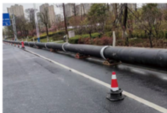
嘉兴平湖DN500拖拉管 一次性拖拉350米
