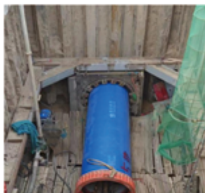
武汉污水治理管网工程 DN1000顶管
