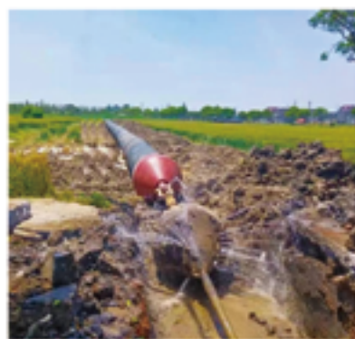
嘉兴平湖DN800拖拉管一 次性拖拉360米
