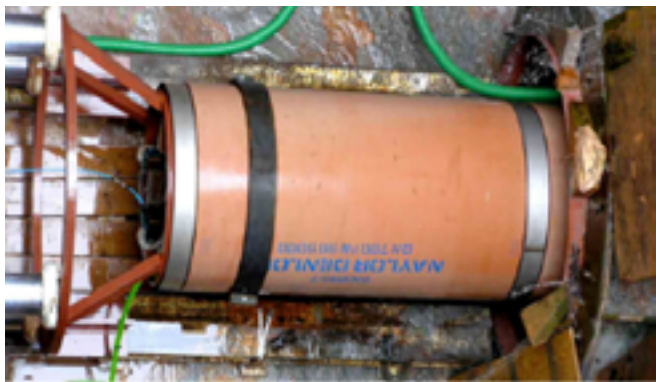
图 2-77 使用 Naylor Denlok 顶进进行插管修复
