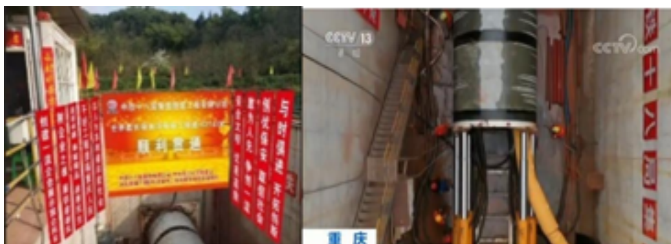
图 2-48 创世界纪录的重庆引水隧道 3224m 顶管工程
