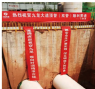
新乡南水北调配套工程 东线DN1200顶管
