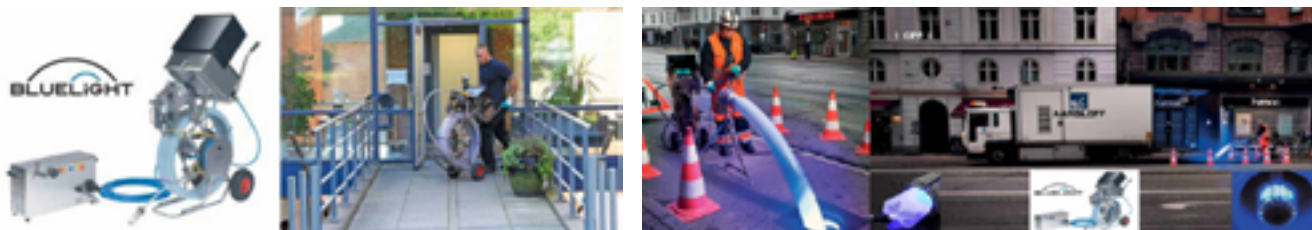
图 2-85 BLUE LIGHT LED 固化系统与施工
