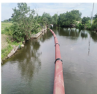
浙江嘉兴城乡供水DN700 拖拉管一次性拖拉312米
