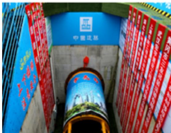
图 2-49 湖北黄冈综合管廊顶管工程
