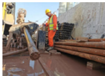
图 2-35 跨河流工程勘察 HDD 取心钻进施工图
