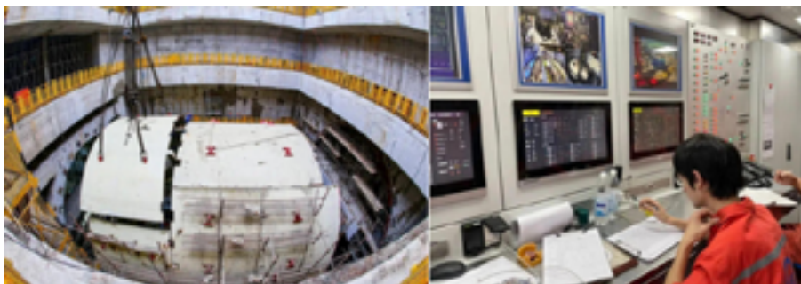
图 2-64 上海机场联络线盾构施工
