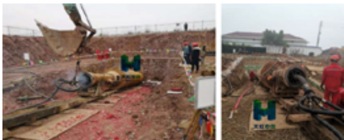
图 2-66 南充市原水管道穿越嘉陵江工程
