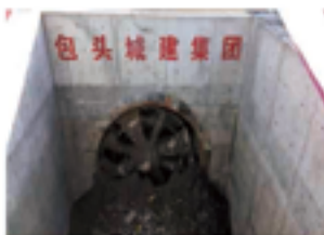
呼和浩特市轨道交通电力通道顶管工程
