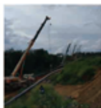
昆明市东绕城隧道及拓建路定向钻穿越工程(钢管)
