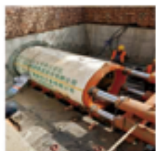
包头市西河沿平污水管线工程
