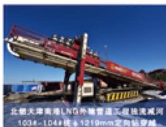
北燃天津南港LNG外输管道工程独流减河 97#-98#桩 \phi 1219mm定向钻穿越
