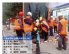
江西新余市两江黑臭水体整治项目排水管道修复工程
