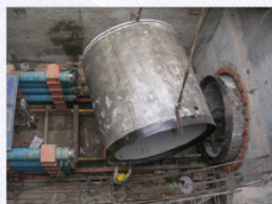
安装顶进管节
