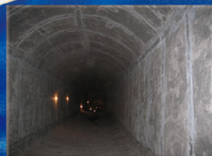
电力隧道防水
