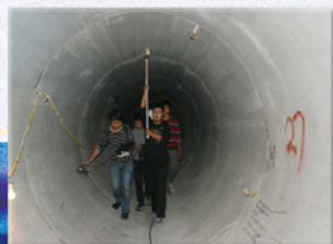
顶管内部雷达检测
