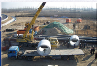
燃气顶管工程
