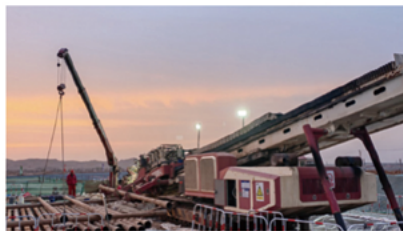
600吨水平定向钻机施工场景
