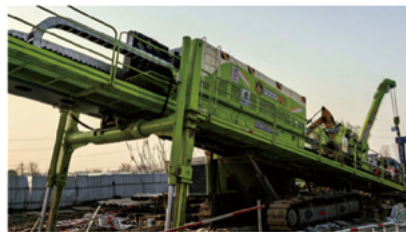
1000吨水平定向钻机水平定向钻机施工场景
