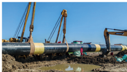
穿越河流工程（DN1422x32.1mm）
