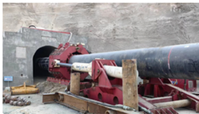
500推管机隧道工程
