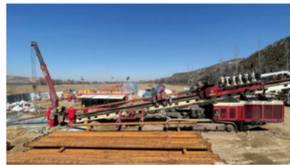
800吨水平定向钻机施工场景
