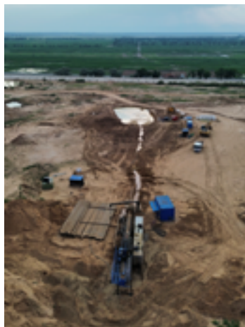
图 4 一号钻正在回拖
