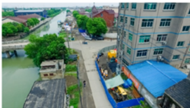
图 7 施工现场俯视
