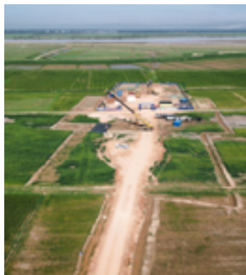
图 6 一号钻管道回拖作业带
