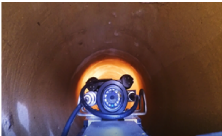
图4 CCTV管内爬行实拍图
