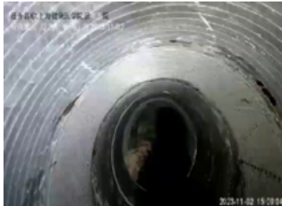
修复后管道照片
