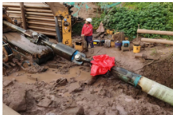
图 14 管道回拖成功
