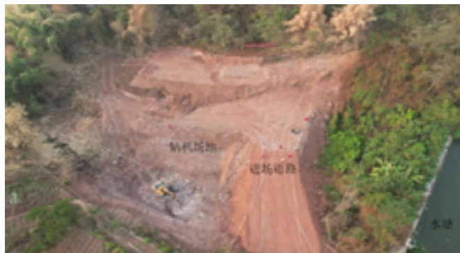
图 5 入土点场地修筑航拍图
