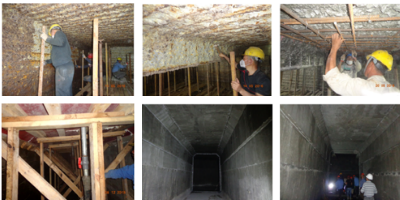
图8 污水泵站模筑工法施工
