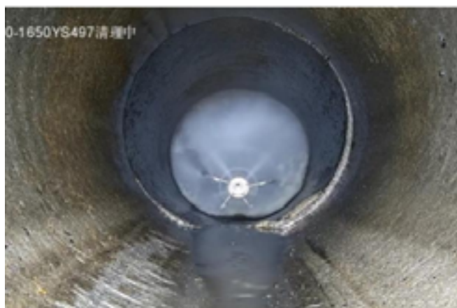
图 4.2-3 高压水射流清洗
