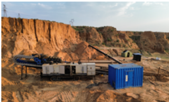
图 5 DDW-360 吨钻机正在拖管
