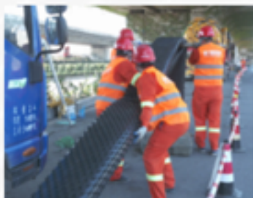
管网零开挖修复
