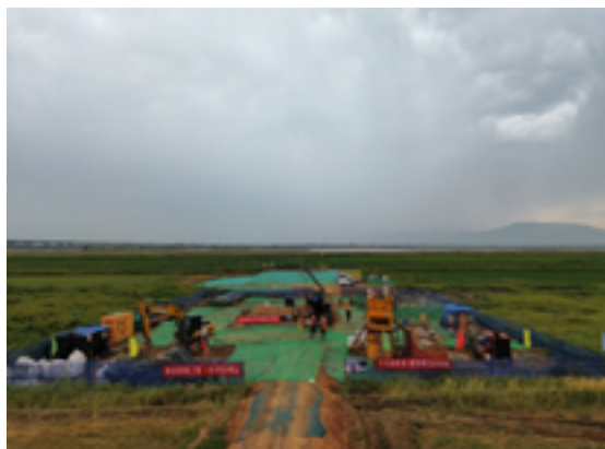
图 8 辅助钻机 DDW-360 钻机施工作业场地全景
