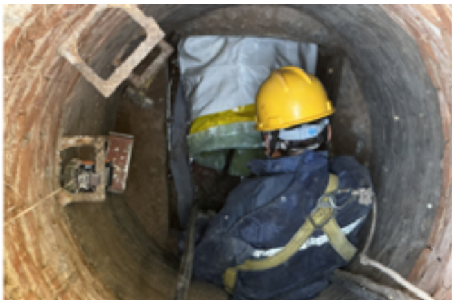
图 4.2-8 为扎头安装过程
