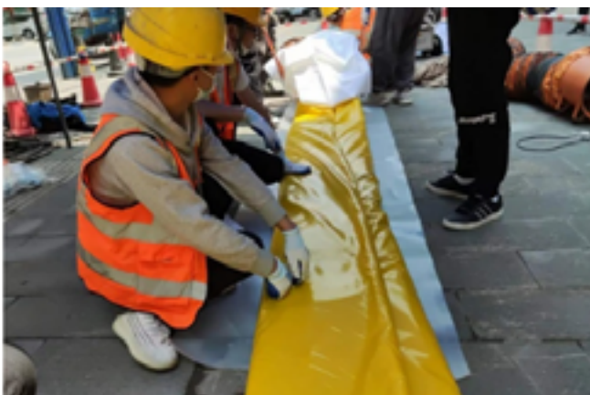
图 4.2-6 软管折叠及牵拉现场
