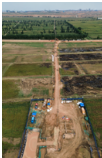
图 11 二号钻管道回拖全景
