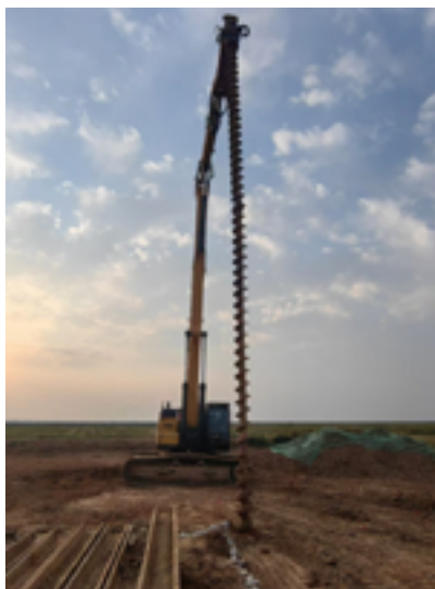
图 14 现场打降水井
