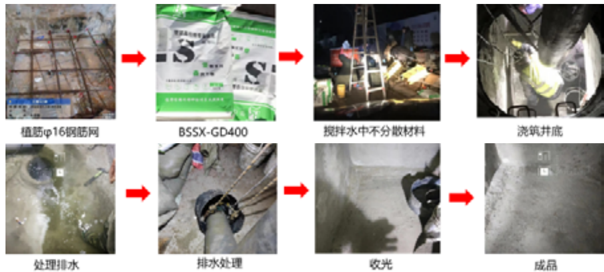
图 2 井底水中不分散材料浇筑
