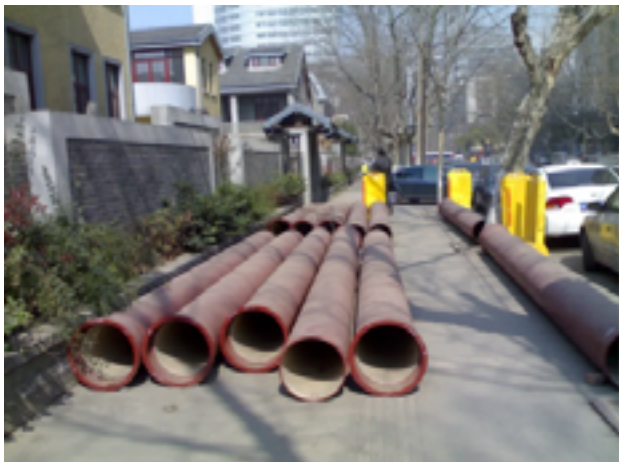
南京市2010年排水管网改造工程中使用的穆松桥排水管道
