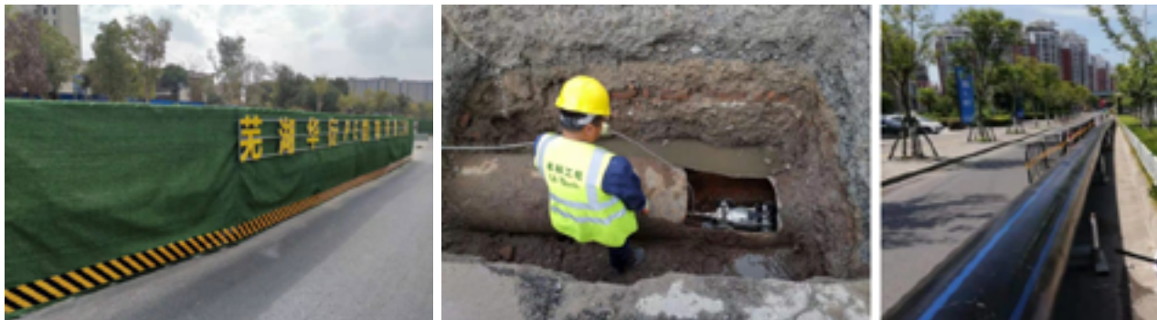
图 12 芜湖九华中路 DN600 供水主管非开挖插管修复项目现场照片
