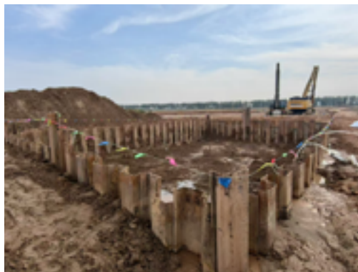
图 15 打卡森钢板桩支护
