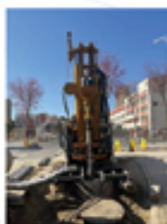
设备安装完毕
