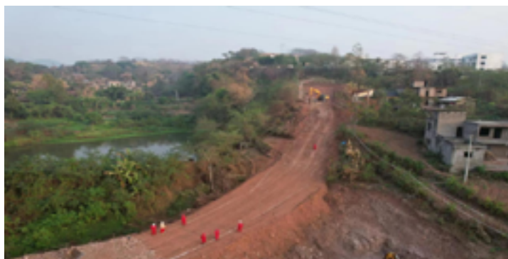
图 4 入土点修筑进场道路航拍图
