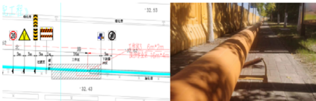
图 13 徐州市湖北路燃气管道插管修复项目现场示意图 / 现场照片
