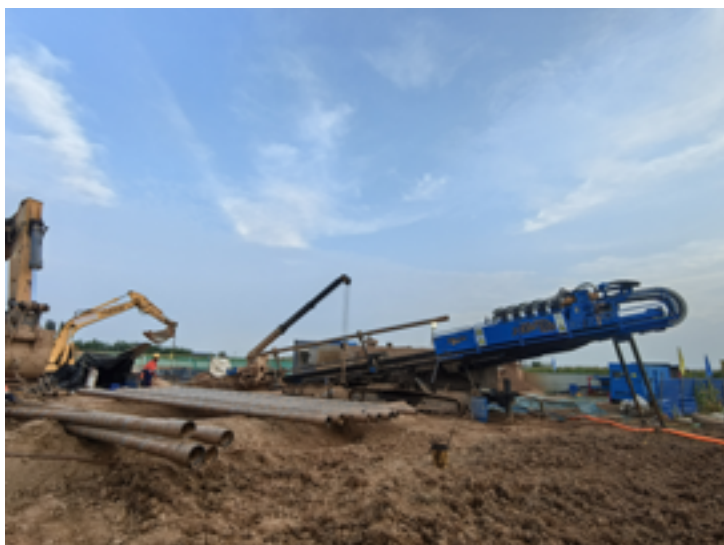
图 10 DWW-800 钻机正在回拖管道
