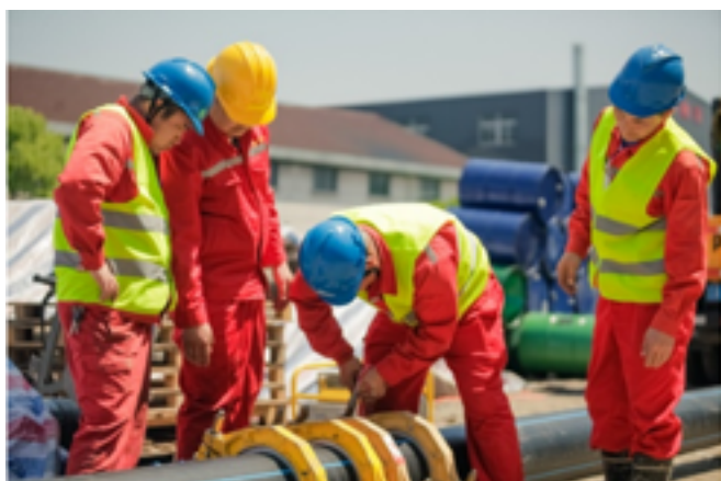
图 9 PE 管道全自动焊机组对焊接
