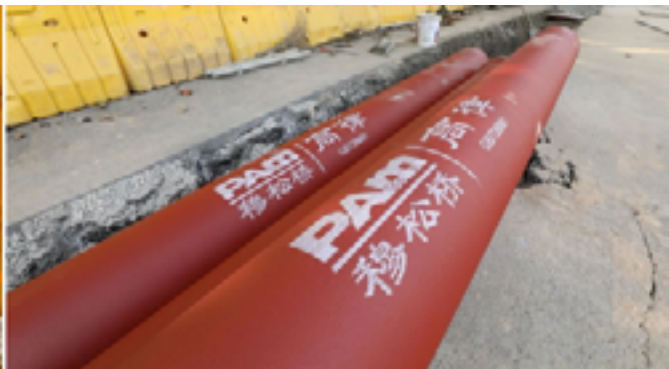
替换后（高律排水管道） 球墨铸铁材质，高环刚度喷锌层 + 高铝水泥内衬，内外防腐优秀
