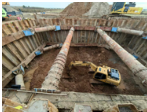
图 16 基坑开挖
