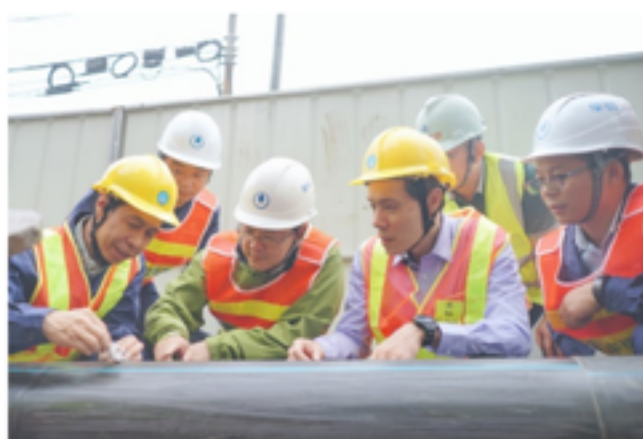
图 10 PE 管道划伤外观质量检查图
