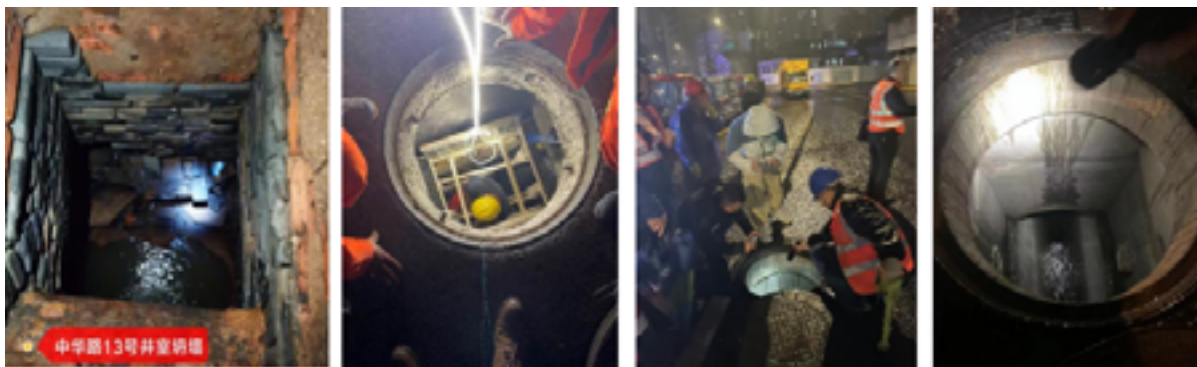
图 1 修复前、支模中、领导视察、模筑后
