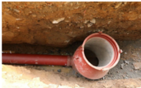
内部为高铝水泥内衬,外部采用富锌漆和合成 树脂漆双重防腐,内外抗腐蚀性更强
