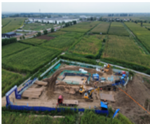
图 7 主钻机 DDW-800 钻机施工作业场地全景
