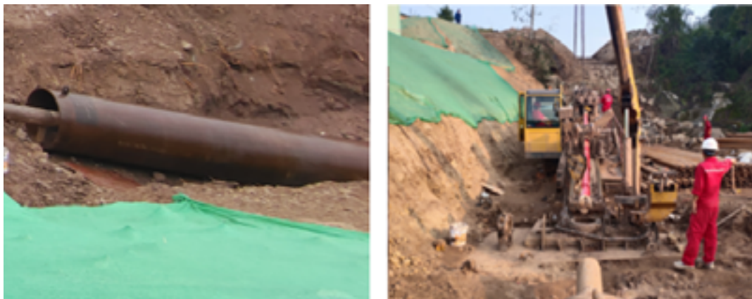
图9 出土点旁 \phi 1016 套管下 \phi 325\text{mm} 中心套管图
