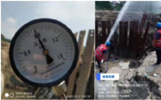
图 6 管线水压试验
