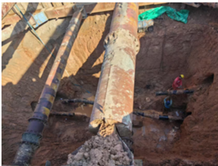
图 17 基坑内管道连头
