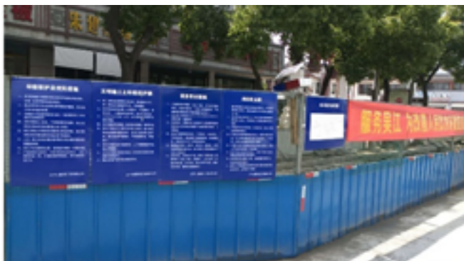
图 8 安全文明施工
