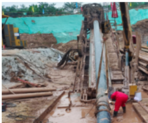
图 8 入土点套钻 \phi 405\text{mm} 套管图
