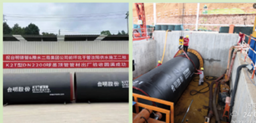
2023年台明铸管助力国内单段长度最长全岩石过山顶管 河南汝阳供水DN2200(单段1.5km)项目顺利竣工
