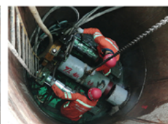
新兴铸管DN300*1米微顶管助力上海临港新区建设
