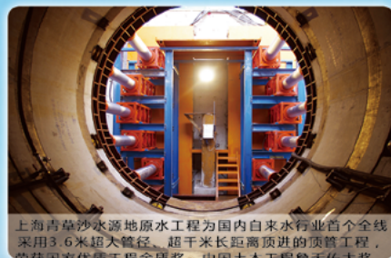
上海市黄浦江上游水源连通管道工程C5标工程荣获全国优秀焊接工程
