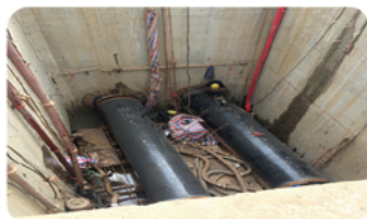
王英水库引水岩石顶进工程
