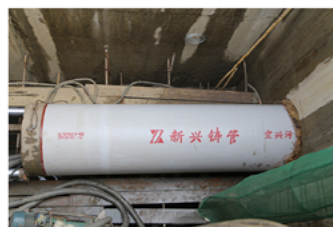
新兴顶管用于江苏省宜兴市污水输送（口径：DN1200mm 长度：2000米）
