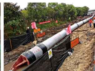
上海南汇老旧管网改造项目（口径：DN1000mm 长度：252米）
