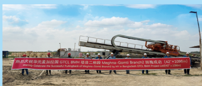
孟加拉国天然气管道水平定钻穿越 (EPC) 工程
