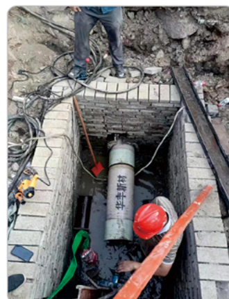
浙江省宁波市杭湾金融港 DN400微顶短管置换
