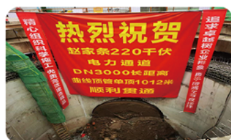
赵家条220千伏电力通道土建工程
