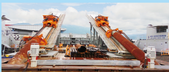
华元香港机场海底穿越项目两台钻机并行施工
