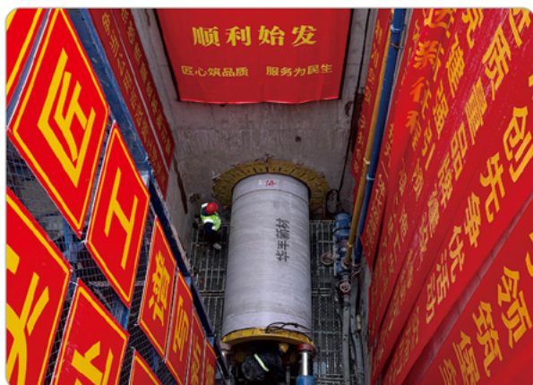
浙江省温州市龙港循环经济产业园 DN2000顶管
