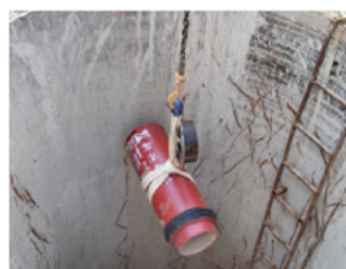
新兴铸管研发生产的DN300球墨铸铁自锚式短顶管在江苏徐州污水项目中首次成功应用
