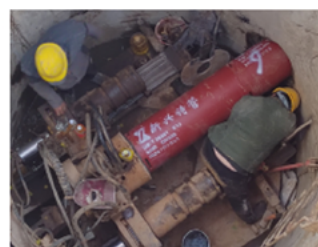
新兴铸管研发生产的DN300球墨铸铁自锚式短顶管在江苏徐州污水项目中首次成功应用
