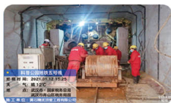
武汉轨道交通5号线科普公园站工程
