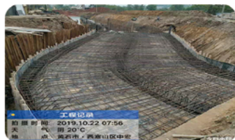
河口排洪港建设工程
