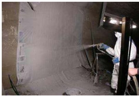
图 2-86 改进后的玻璃纤维贴片法修复
