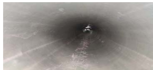
图 2-79 北京隆科兴 UV-CIPP 修复压力管道
