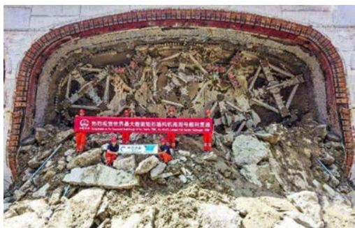
图 2-60 中国最大断面盾构机顺利贯通
