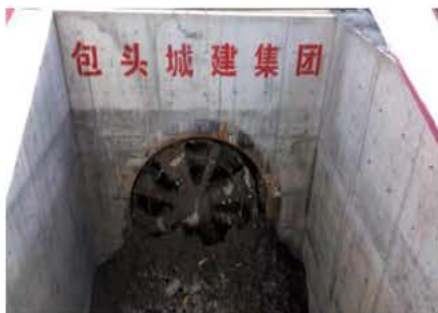
呼和浩特市轨道交通电力通道顶管工程
