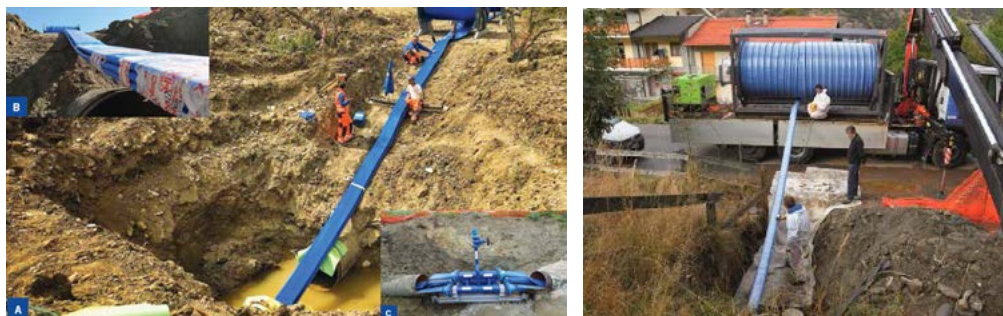
图 2-75 Primus Line® 普莱姆斯软管法施工
