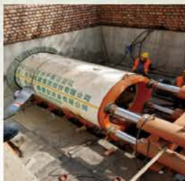
包头市西河总干 污水管线工程
