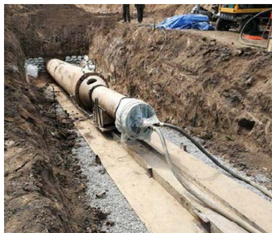
图 2-63 浈江穿越的夯套管基坑与设备就位
