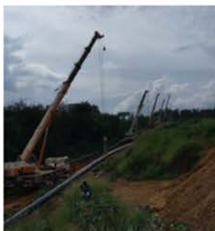
昆明市东绕城匝道及拓翔路 定向钻穿越工程(钢管)
