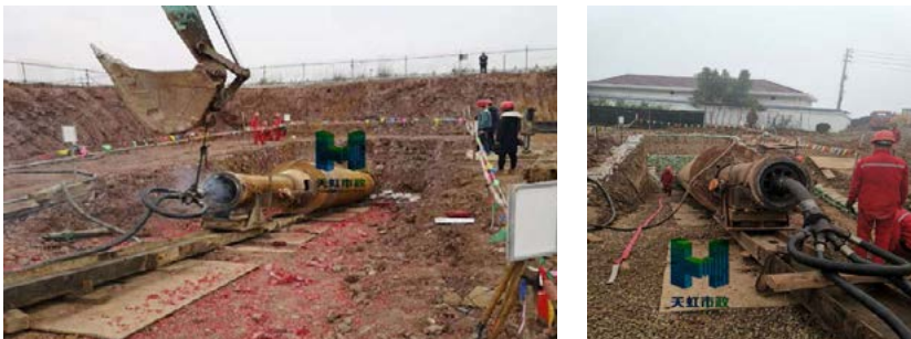
图 2-64 南充市原水管道穿越嘉陵江工程
