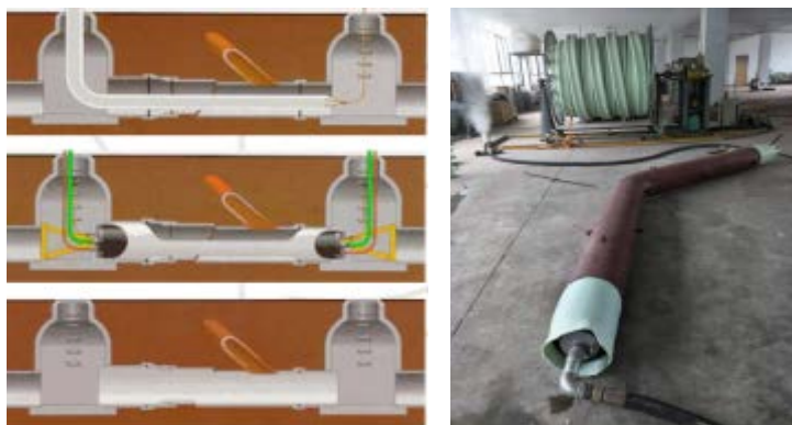
图 2-74 热塑料成型工法与试验
