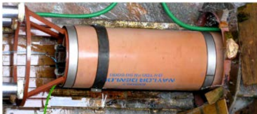
图 2-73 使用 Naylor Denlok 顶进进行插管修复
