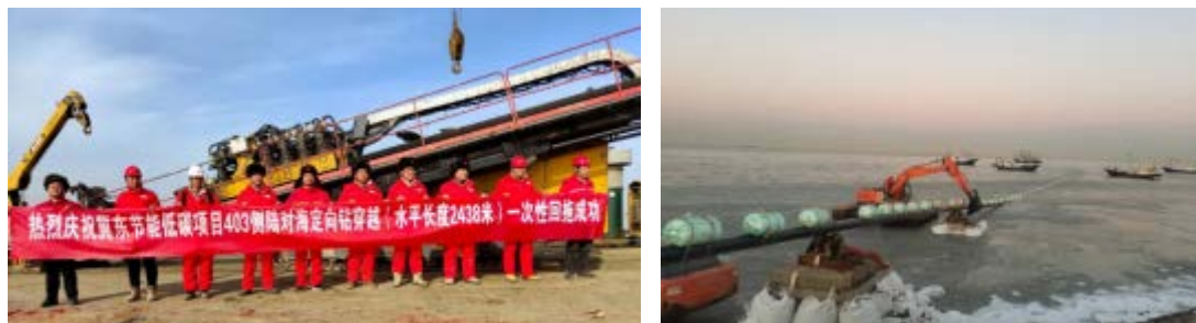
图 2-30 冀东油田 403 侧陆对海穿越工程
