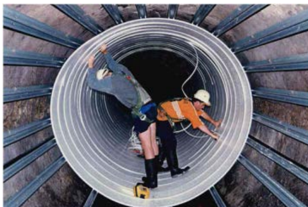
图 2-77 APS 迪拜公司的工人安装 Danby 螺旋缠绕内衬管
