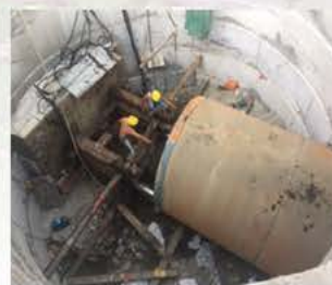
成都市地铁6号线东光站 排水管线迁改工程
