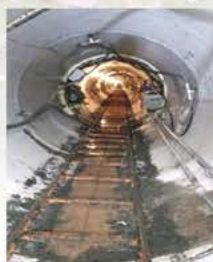
包头市供水管网扩能 改造项目第三批2标段 给水管线顶管工程
