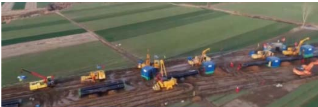
图 2-29 滹沱河定向钻穿越工程
