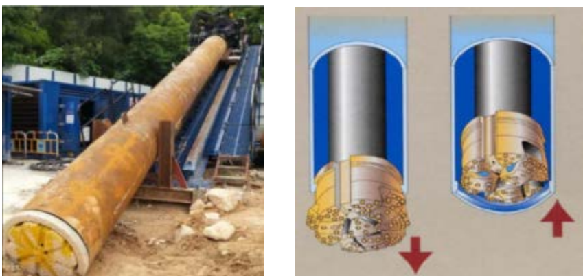
图 2-65 潜孔锤跟管钻进安装套管
