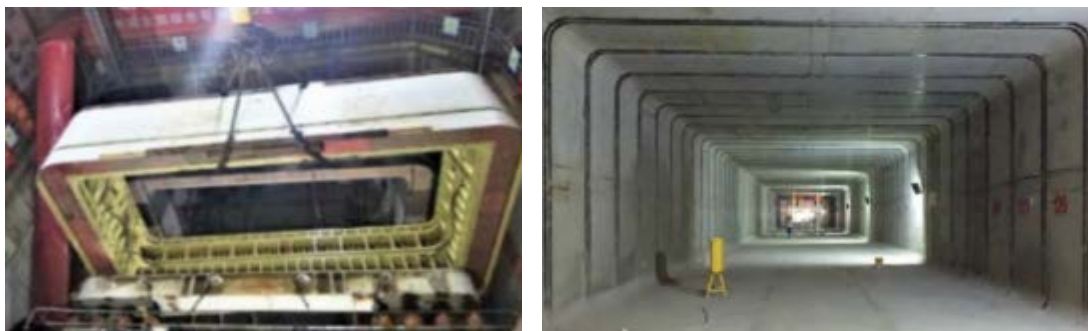
图 2-54 苏州城北路大断面矩形顶管中继间和管廊通道内景
