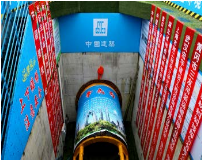
图 2-48 湖北黄冈综合管廊顶管工程
