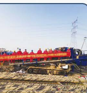
DDW6000 钻机在扬州高邮湖 1016 钢管*1042 米施工
