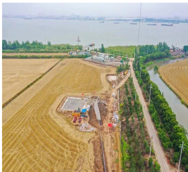
马洲岛拉管施工作业现场
