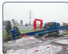
DDW6000 钻机在扬州高邮湖 1016 钢管*1042 米施工
