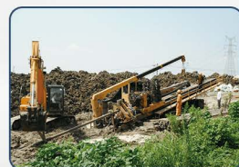
ZT-150T钻机在施工
