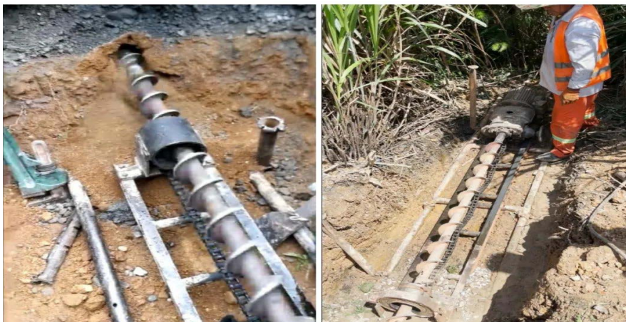
地下横向钻孔排水
