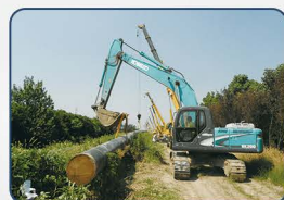
江阴暨南大道1480米Φ508燃气管拉管施工
