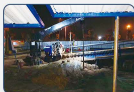
DDW6000 钻机在扬州仪征泥质砂岩 1016 钢管*964 米施工
