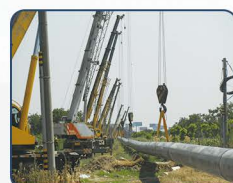
常熟虞昆线1023米Φ610燃气管拉管施工
