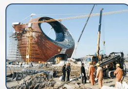
ZT-150T钻机在无锡自来水管施工
