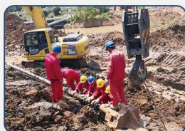
DDW6000 钻机在扬州仪征泥质砂岩 1016 钢管*964 米施工
