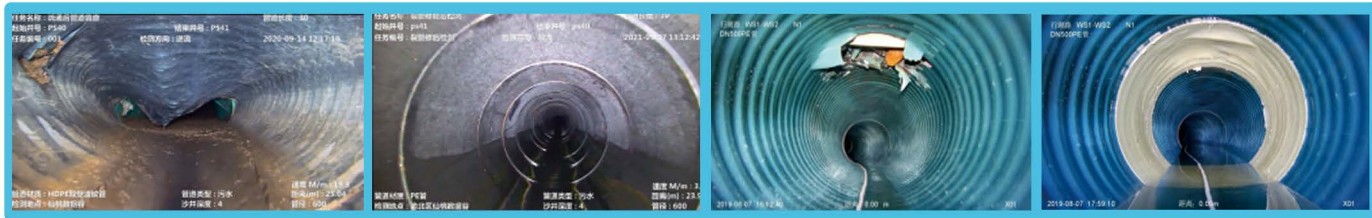
静压裂管修复前后
