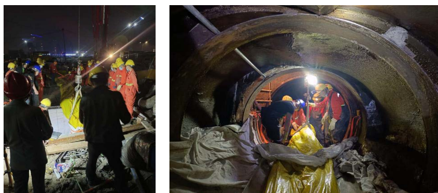
将内衬软管材料拖入管段中
