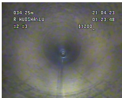
图 8 超高压清洗管道后管道内状况
