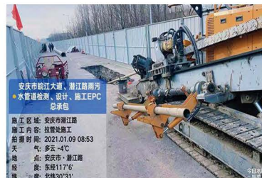
安庆市皖江大道、潜江路雨水管道检测、设计、施工EPC（杭州市政）
