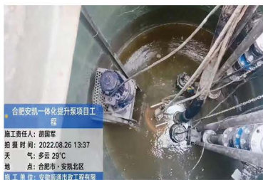
合肥安凯小区——一体化泵站工程（中铁上海局）
