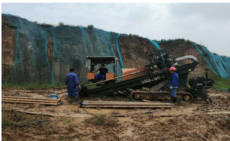
管线施工实景图
