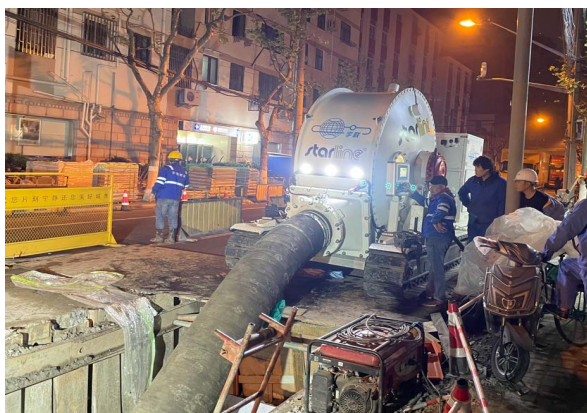
图 10 CIPP 常温固化翻转内衬修复施工
