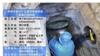
图 3 管口封堵
