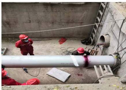
焊接、检测、牵引拉管
