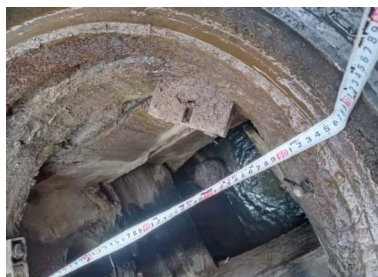
图 5 测量检修井口径
