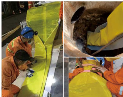
抗UV共挤阻隔膜、防锈膜等功能性薄膜材料在管道修复中的应用。
