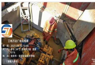
天柱山东路（万达广场北侧至安庆职业技术学院南侧）污水管道驳接工程（万达集团）
