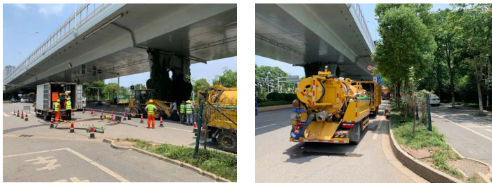
施工前现场围蔽
