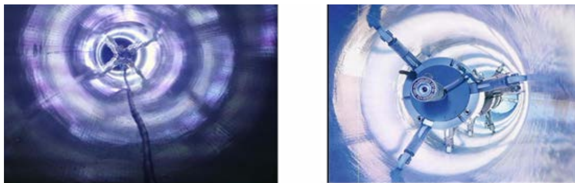
图 9 紫外光固化
