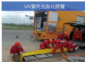
UV紫外光固化修复
