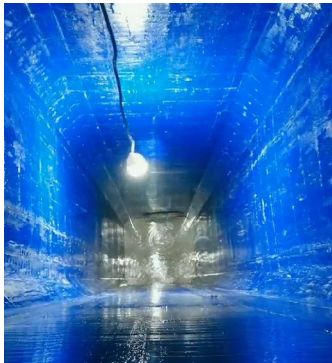
图 5 修复后内衬井外观检测
