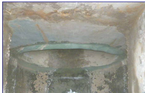
图 3 检查井内管道端部情况
