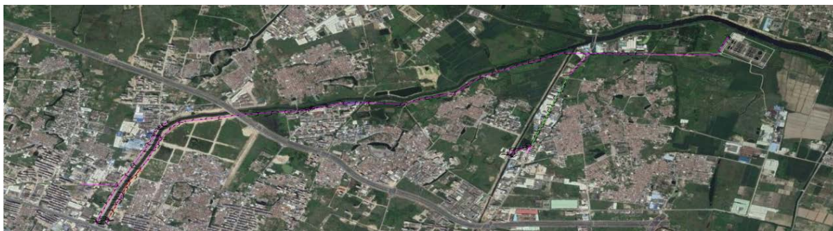
某市污水处理厂一期配套 9.3 公里主管网(满水干管)检测服务项目
