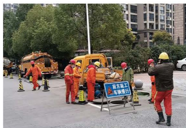
雨污水管网修复工程（绿地集团）
