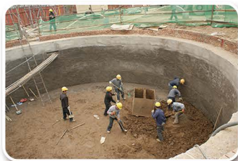
圆形顶进坑施工
