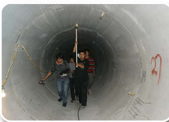
顶管内部雷达检测
