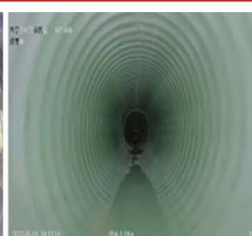
热塑成型修复后
