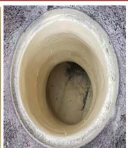
美得威高强度防腐水泥砂浆 MDW-72喷涂后
