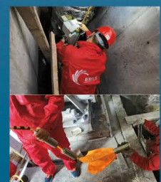
某市压力管道不停 输内检测项目
