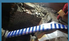
某市DN500供水管道 柔性内衬修复项目
