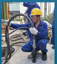
某市检查井离心喷涂修复
