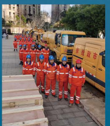
某市排水管网清淤、紫外线光固 化修复项目
