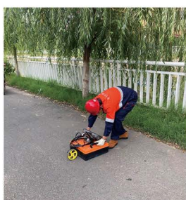
■ 商丘地下燃气 管道探测项目
