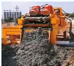
ZX-100B用于定向钻施工
