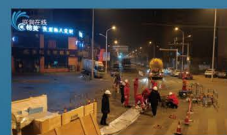
某市老旧管网改造EPC工程
