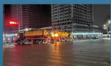
污水管网清淤项目
