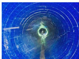
管片模块拼装管道修复
