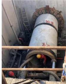
■ 浙江舟山 \phi 1800mm 水泥顶管项目
