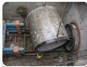
安装顶进管节
