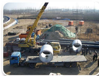
南六环太和东桥燃气顶管施工现场
