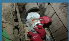
某市DN1000自来水紫外光固化内衬 修复项目修复项目
