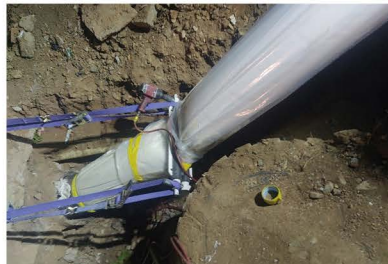
■ 葫芦岛D406mm钢管翻转内衬修复项目
