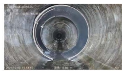
芜湖非开挖管道修复项目
