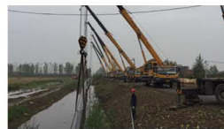
宁波跨海定向钻穿越项目
