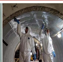
玻璃钢增强修复管道
