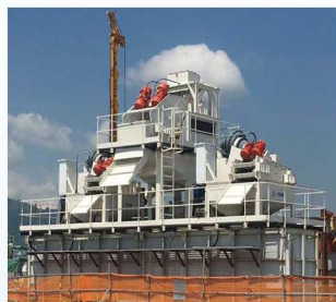
ZX-500用于顶管工程
