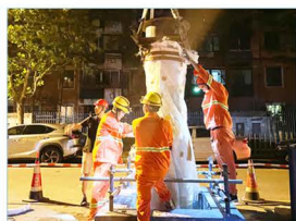
检查井整体内衬修复
