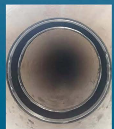
大口径承插口不锈钢双胀圈修复
