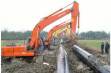
丹阳自来水定向钻穿越项目
