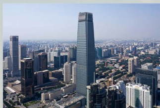
中国国际贸易中心三期燃气工程
