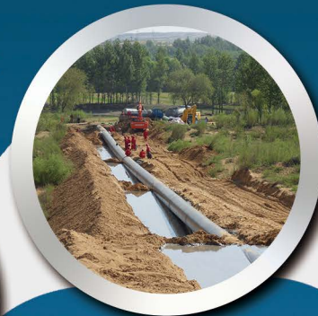
8管线发送 (陕京三线榆溪河 \phi 1016 \times 870\text{m} )
