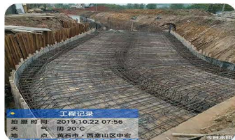
河口排洪港建设工程
