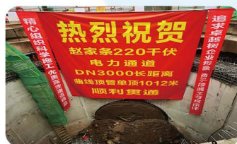
赵家条220千伏电力通道土建工程
