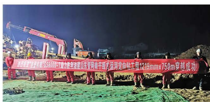
胜利油建山东管网南干线古运河定向钻
