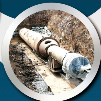
长吉线岔路河穿越段 安全改造工程—夯锤施工
