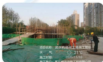
武汉市黄孝河、机场河水环境综合治理二期PPP项目工程
