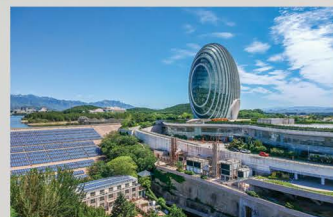
APEC日出东方酒店能源中心项目
