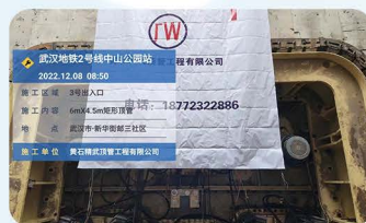
武汉市轨道交通2号线中山公园站矩形顶管工程
