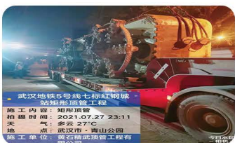
武汉市轨道交通5号线第七标段红钢城站矩形顶管工程
