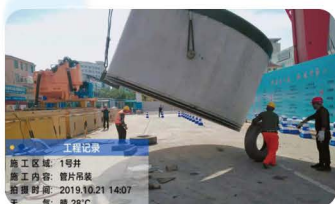
黄冈市地下综合管廊PPP工程
