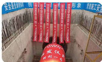
青菱路电缆隧道沉井及顶管工程
