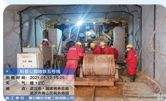
武汉轨道交通5号线科普公园站工程
