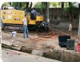
古大同盐厂门口XZ320D水平 定向钻机顶进现场
