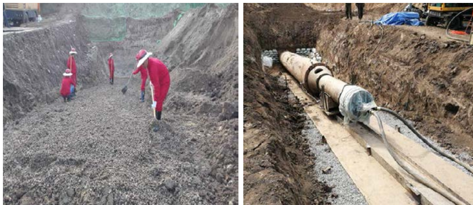
图 2-37 滇江定向钻穿越工程夯套管基坑与设备就位
