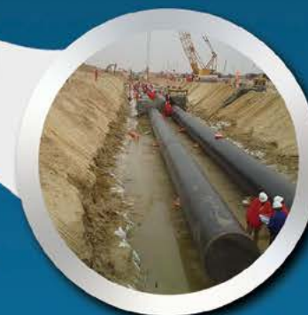
中委合资广东石化2000万重质原油 加工工程厂区给排水消防网管 工程沟下焊接
