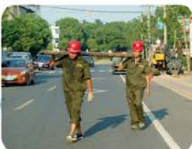
大同西路XZ200水平定向 钻机卸钻杆现场
