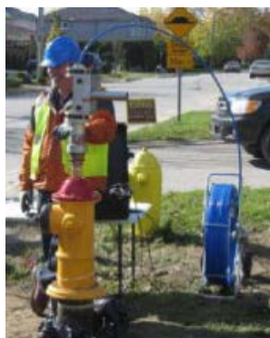
图 2-64 典型的小直径 CCTV/声学检测装置
