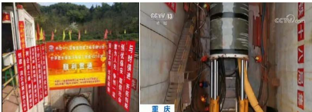
图 2-27 创世界纪录的重庆引水隧道 3224 m 顶管工程
