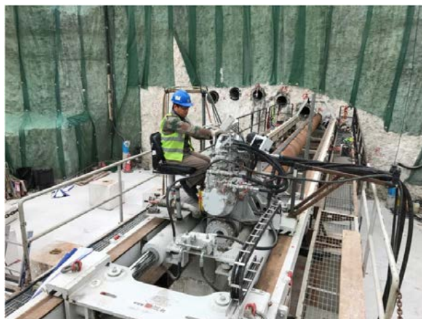
图 2-39 隧道圆拱上的 Bohrtec BM 600 LS
