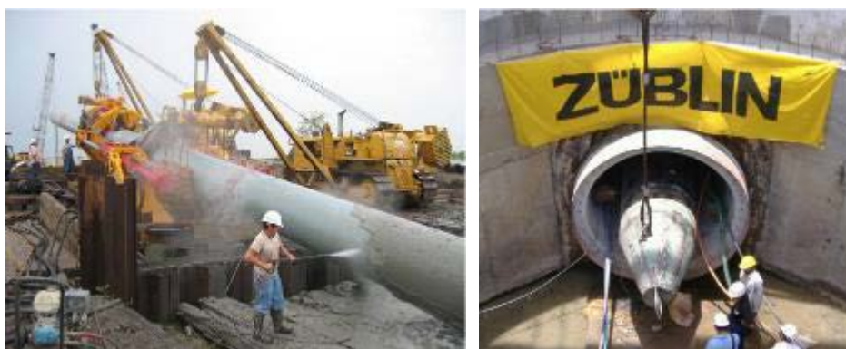
图 2-42 回收旧管道和管内铺管
