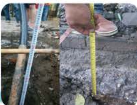
施工现场测量
