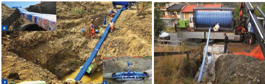
图 2-46 Primus Line® 普莱姆斯软管法施工
