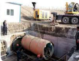
新疆TPN1500施工现场
