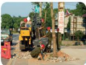
大同西路XZ200水平定向 钻机顶进现场
