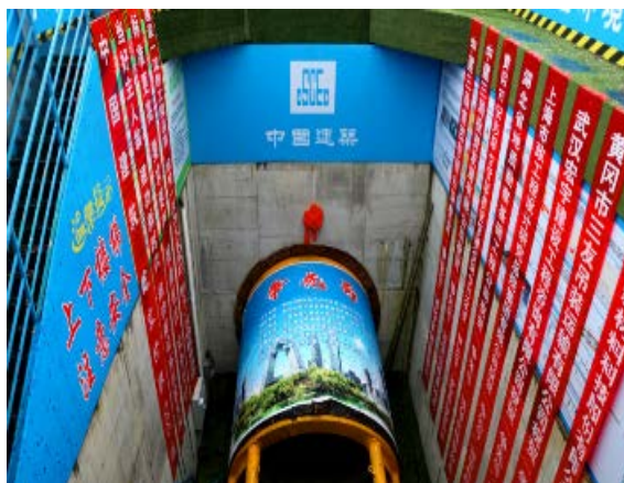
图 2-28 湖北黄冈综合管廊顶管工程
