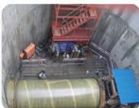
上海TPN1220钢管顶进现场
