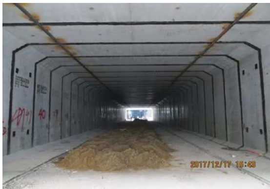
图 2-26 武汉地下人行通道采用矩形顶管
