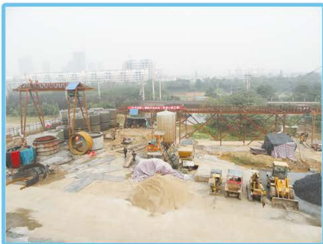
工地现场制做大口径砼管
