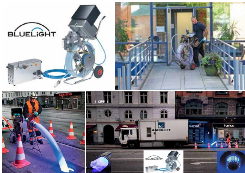
图 2-45 BLUELIGHT LED 固化系统与施工
