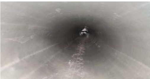
图 2-52 北京隆科兴 UV-CIPP 修复压力管道
