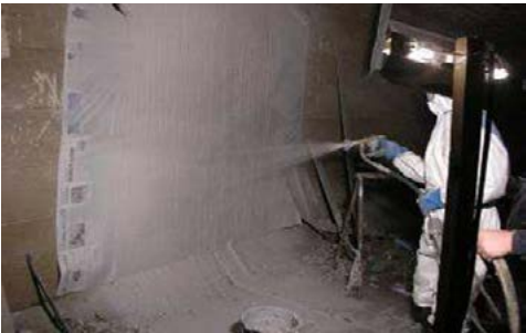
2-51 改进后的玻璃纤维贴片法修复
