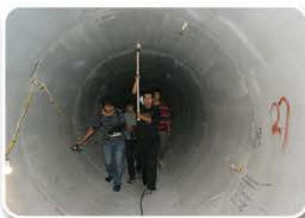
顶管内部雷达检测
