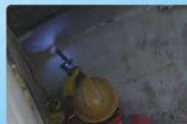
固化后端口切割
