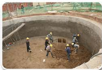
圆形顶进坑施工
