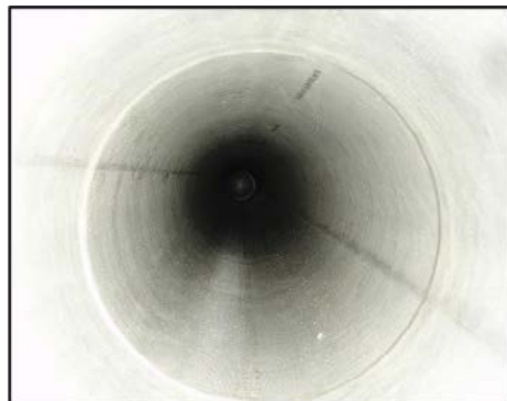
图 8 管道经修复后情况
