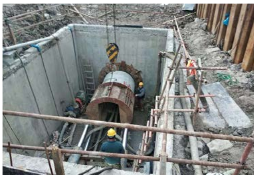
淤泥层水泥顶管施工现场
