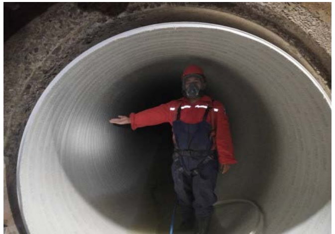
大口径管道修复
