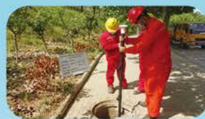
排水管网检测
