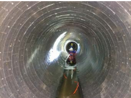
图 3 内衬管外观验收检测
