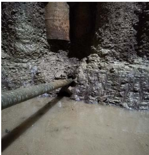
导向顺利进入热力深基坑内
