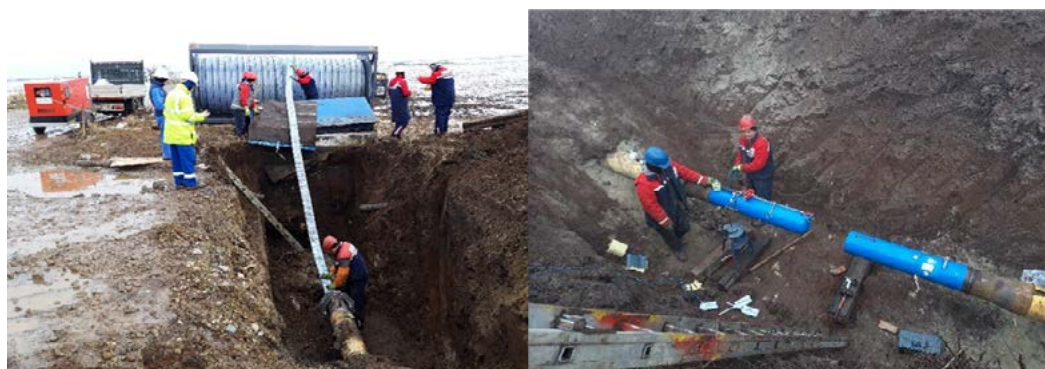
图 6 图 7 现场施工作业中
