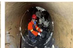
污水管道非开挖修复后
