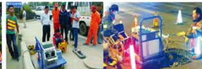
管道机器人CCTV检测
