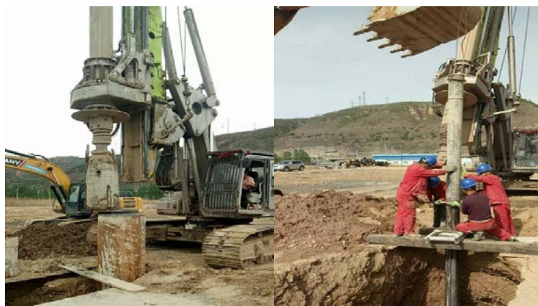
旋挖钻施工
