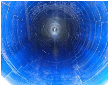
图 4 内衬管外观验收检测
