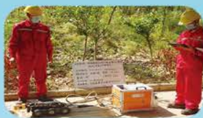
排水管网检测
