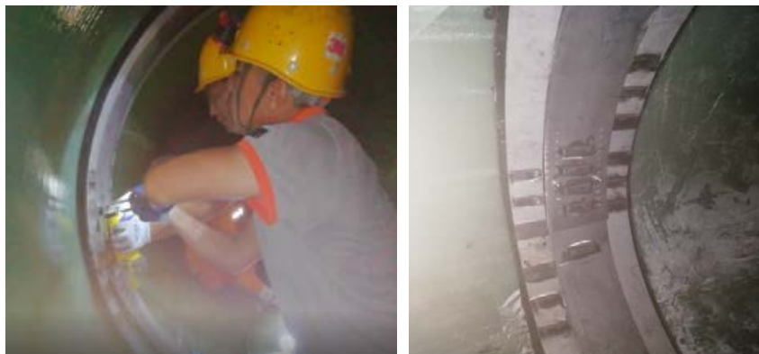
图 5-5 双胀圈连接接口
