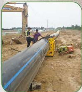
河北管网改造
