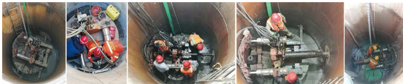
① 设备安装 ② 徕卡导向仪安装 ③ 顶进前导管 ④ 前导管与黑管连接 ⑤ 黑管顶进
