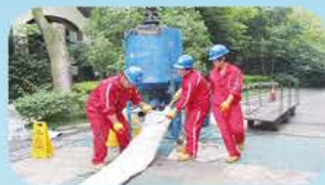
排水管网非开挖修复
