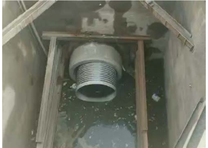
一次性完成 167 米修复
