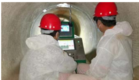
图 5-3 小型分离式固化设备
