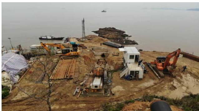
海陆水平定向钻施工现场
