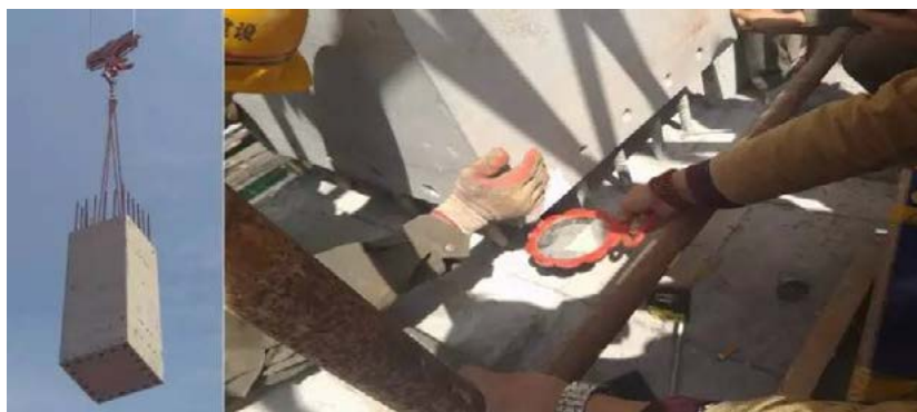
框架柱柱底钢筋连接
