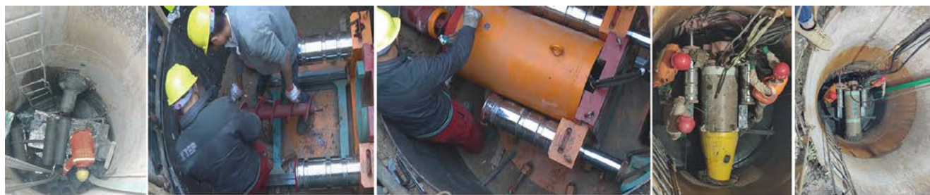
⑥ 出接收井 ⑦ 出土螺旋管安装 ⑧ 安装切削机头 ⑨ 树脂混凝土管顶进
