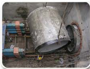
安装顶进管节
