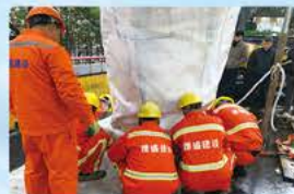
翻转施工前固定端口
