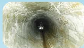
修复后管道内部
