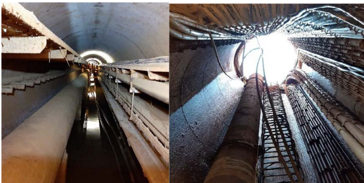
图4 图5 管廊及管井现场照片
