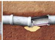
沉降管道顶升复位
