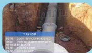
排水管网混错接改造
