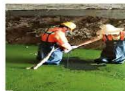
管道河底渗漏处治
