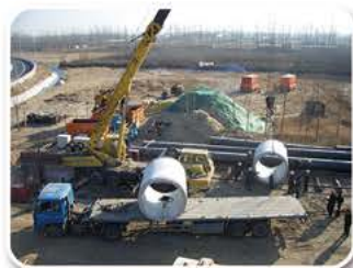
南六环太和东桥燃气顶管施工现场
