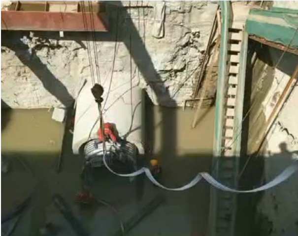
地下 10 米深基坑
