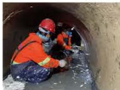
污水管道非开挖修复前
