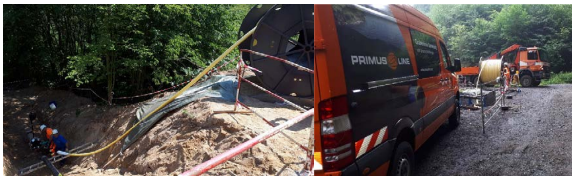
图 8 图 9 现场施工安装中
