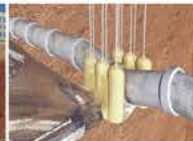
涌水涌沙快速封堵
