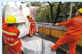
内衬软管准备下管
