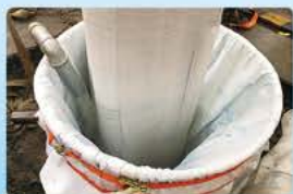
水力翻转送入内衬软管
