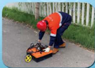
商丘地下燃气管道探测项目
