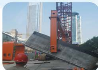
矩形管节翻转及吊装
