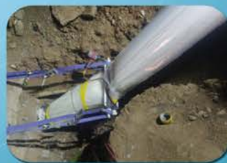
葫芦岛D406mm钢管翻转内衬修复项目
