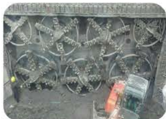
矩形顶管机出洞门
