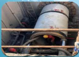
浙江舟山D1800mm水泥顶管项目
