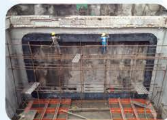
止水橡皮圈安装
