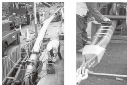
图3 Swagelining (右) 和 Insituguard- 折叠和形成 (左)
