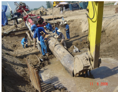
图3.2 准备顶入第一根套管
