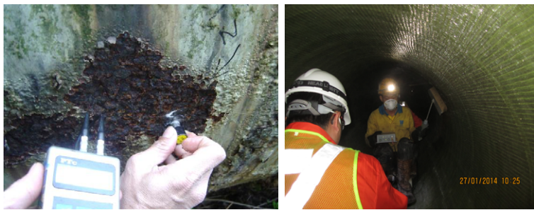
图7 香港东江供水管道加固图
