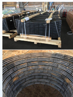
日本支撑板施工
