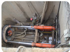
TPN1500顶进现场
