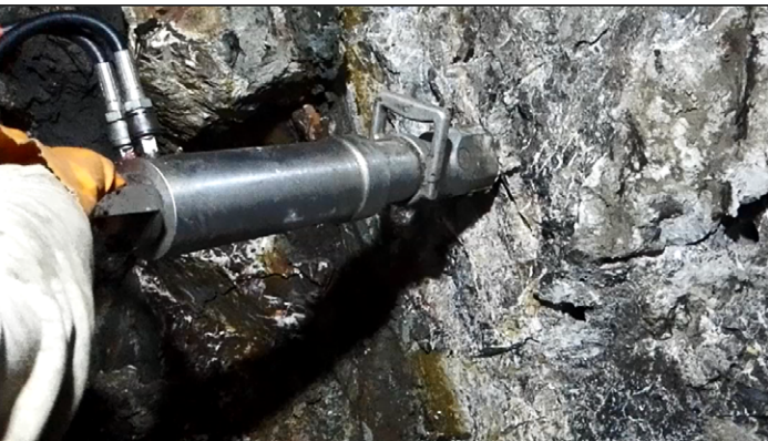
劈裂机劈裂岩石
