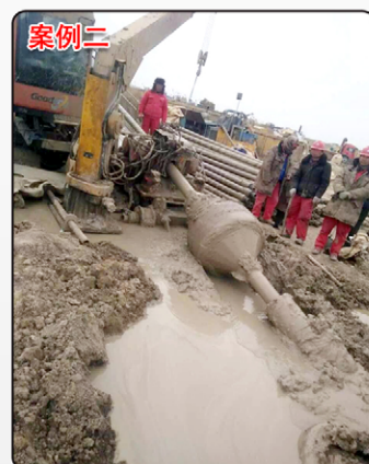
案例二 董家口港-潍坊-鲁北输气管道工程
