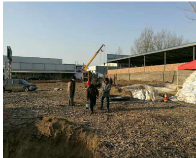
图5施工场地河内管线勘测中
