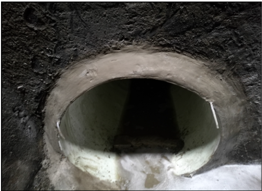
图-4 管口处理后情况
