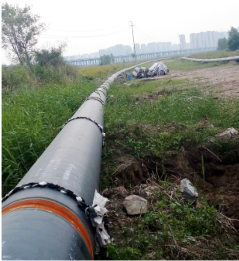
图2 铺设管线图
