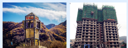
兴隆县燕山峡谷美丽乡村片区建设项目
