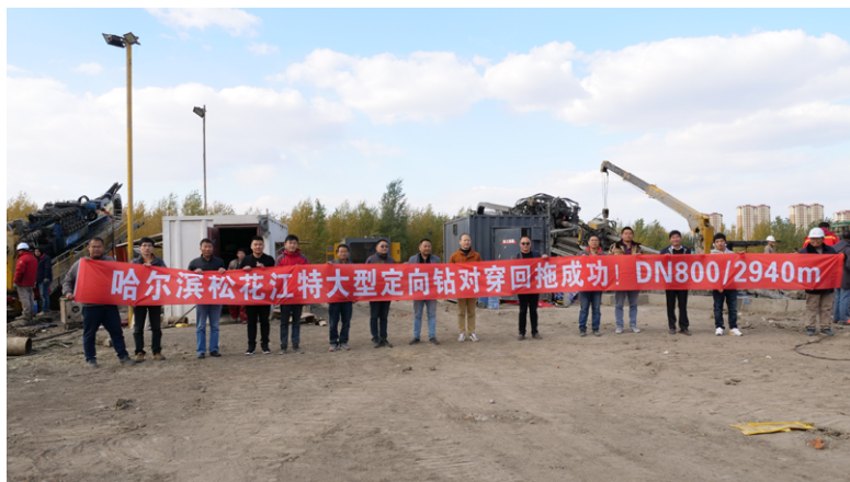
图8 管道铺设成功
