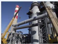
天津联合钢铁厂D=1800管道工程
