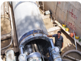
伊朗TPN1400顶进现场
