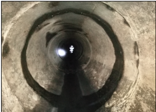
图-5 内衬施工前管内情况
