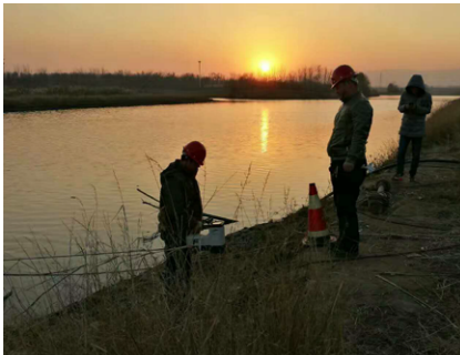
图3施工场地导向中
