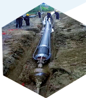
河南省濮阳市第二水源拖管工程
