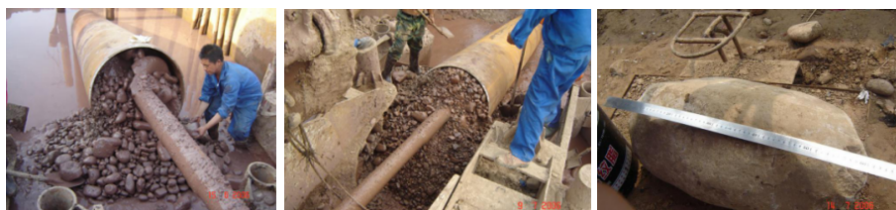
图3.5 施工现场绞龙从套管内排出卵石
