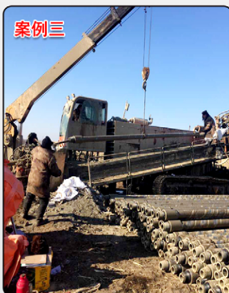
案例三 海门市第二污水处理系统一期上海路污水管网工程
