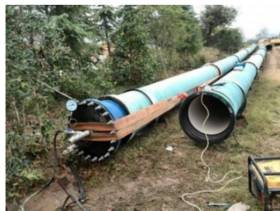
图8 管线试压
