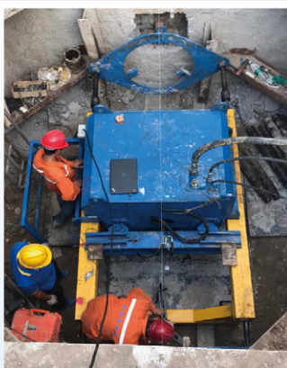
微型顶管（螺旋出土）
