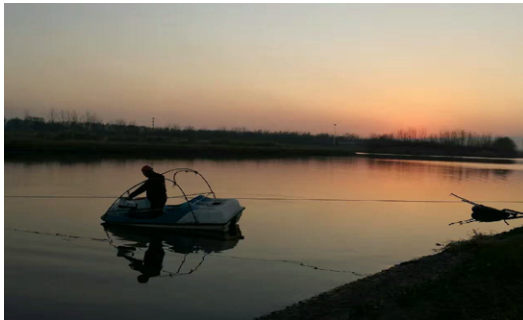
图4施工场地河内导向中
