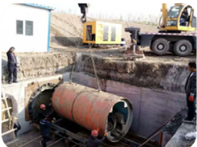
新疆TPN1500施工现场
