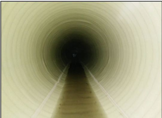
图-6 内衬施工后管内情况
