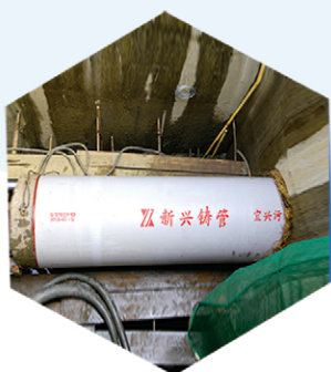
江苏省宜兴市污水输送工程
