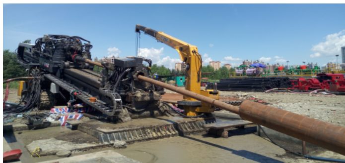
图3 XZ5000水平定向钻机施工现场
