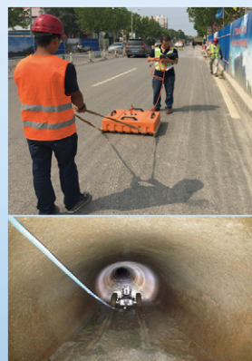
雷达、CCTV检测技术
