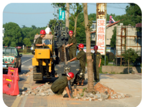
大同西路XZ200水平定向 钻机顶进现场
