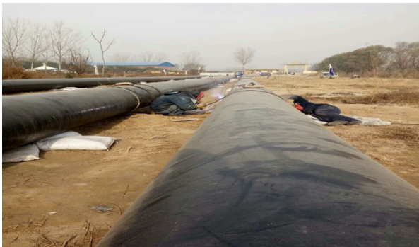
图8-1焊接管道施工场地
