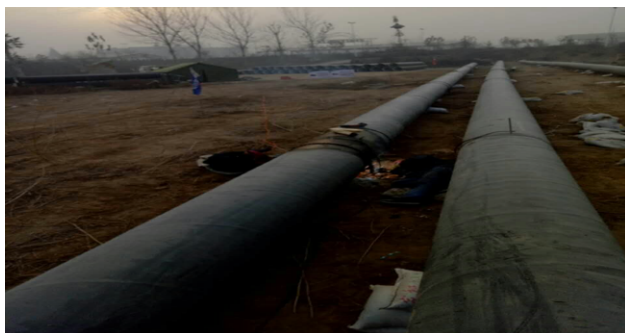
图 2 施工场地焊接管道
