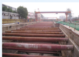
北京地铁深基坑施工
