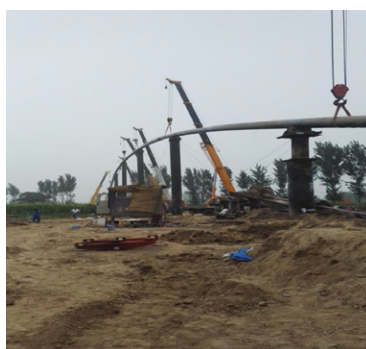
图3.15 顶管发送现场图
