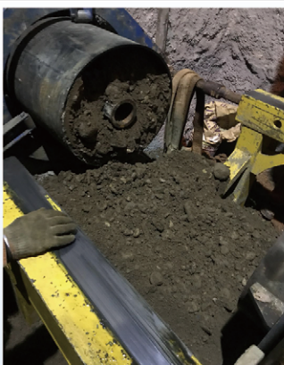
微型顶管（螺旋出土）
