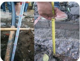
施工现场测量
