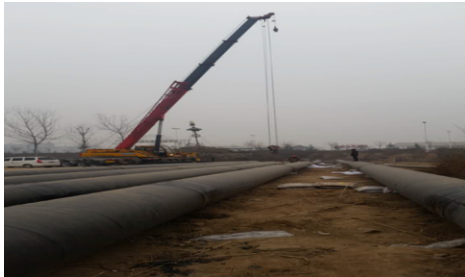
图13 吊装管道作业中
