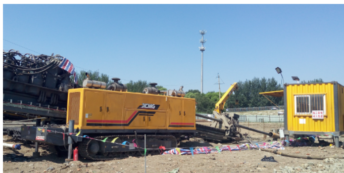
图4 XZ3000水平定向钻辅助钻机施工现场
