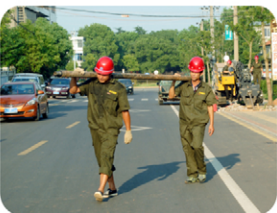
大同西路XZ200水平定向 钻机卸杆现场
