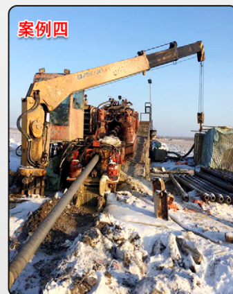
案例四 衡阳市北二环燃气主干管湘江穿越工程
