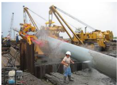
图 2-21 回收旧管道和管内铺管
