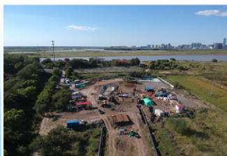
两台600t定向钻机同时施工现场
