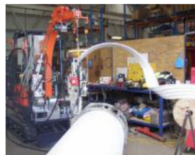
图 2-30 Interflows 公司污水管道非开挖修复工程
