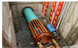
钢管顶进施工
