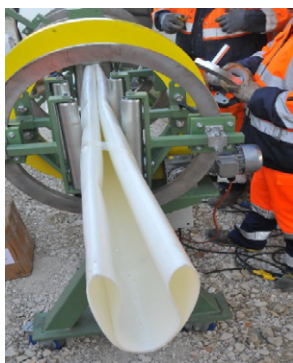
图 2-26 瑞士萨尼维尔公司的双层覆膜软管内衬
