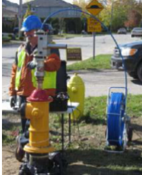
图 2-42 典型的小直径 CCTV/声学检测装置
