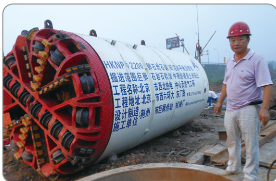
HKNPΦ2200北京西六环千灵山风景区大灰厂路施工现场
