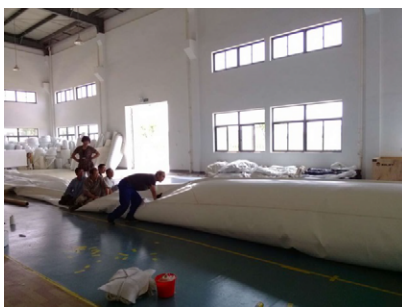
图 2-29 上海管丽公司大直径 CIPP 管道修复
