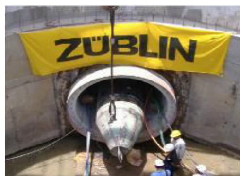
图 2-21 回收旧管道和管内铺管
