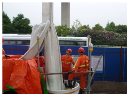
图 2-29 上海管丽公司大直径 CIPP 管道修复
