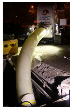
图 2-31 北京天环压力管道 翻转内衬修复
