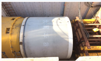
钢筋混凝土管顶进施工
