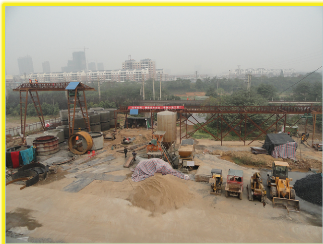
工地现场制做大口径砼管
