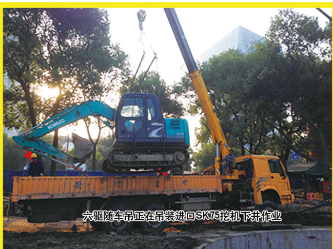
迷你型挖机下井作业
