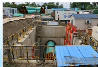
盐城市新水源地顶管安装施工现场
