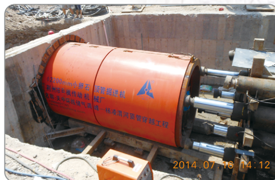
HKTPΦ2200mm小卵石顶管掘进机在陕西西安渭河施工工地
