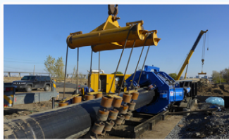
定向钻管道回拖推管机助推钢管
