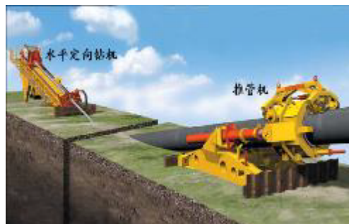
图 2-20 推管机用于辅助回拖作业
