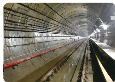
盾构施工完成
