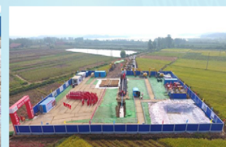
新气长江定向钻施工现场
