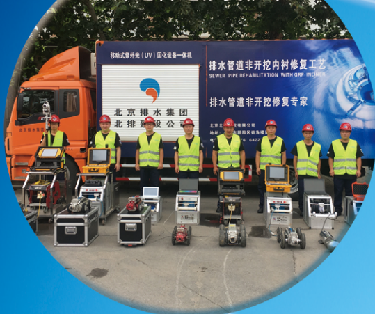
非开挖管道修复技术
