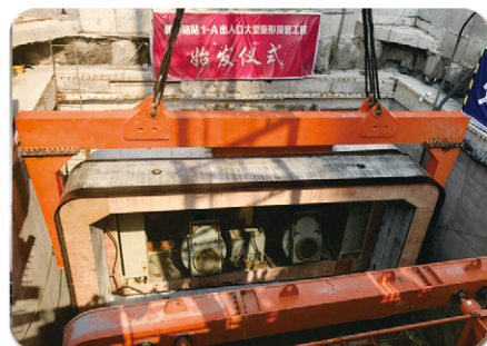
矩形顶管施工
