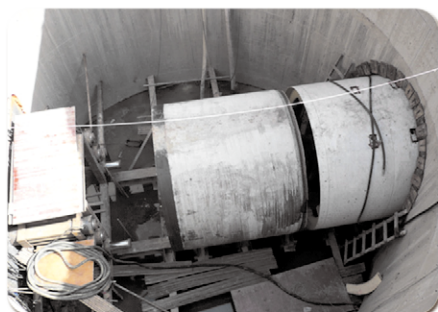
顶管施工
